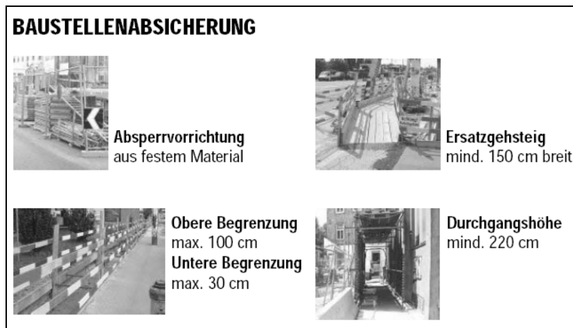
Abb. 3.2 Berücksichtigung behinderter Personen bei Baustellenabsicherungen
