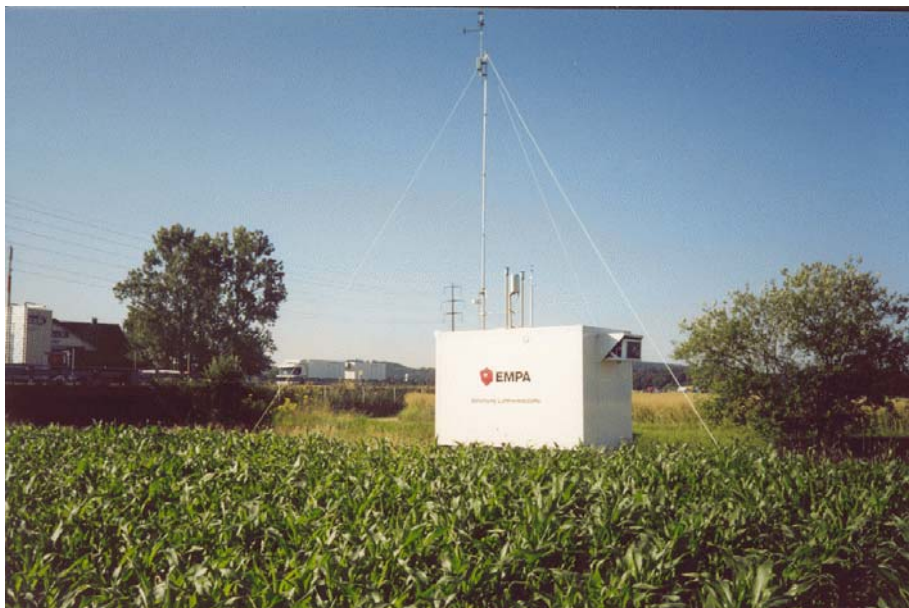
Abbildung 3.3: Messcontainer der EMPA auf der Westseite der Autobahn A1 bei Birrhard.
