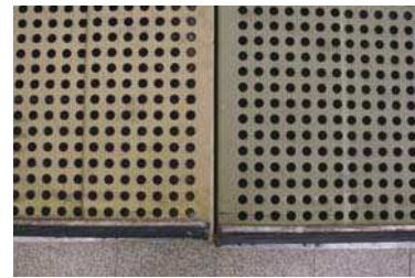
Detail: Sickenblech-Abdeckung mit Rundlochung
