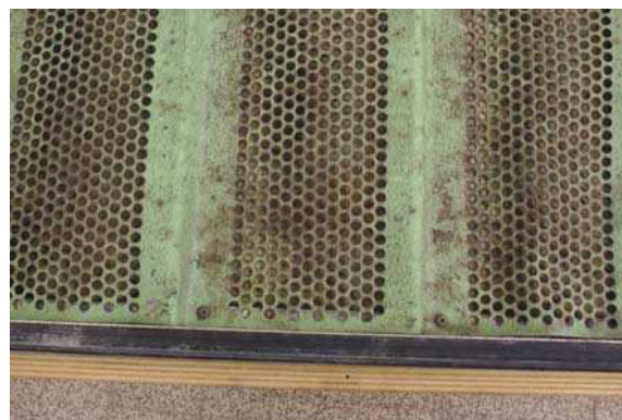
Detail: Mineralwolle abgedeckt durch Z-Bleche mit Rundlochung
