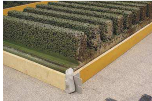
Detail-Ansicht: Rippung des Aufbaus aus haufwerkporigem Leicht- Beton auf Unterlage aus Normal-Beton
