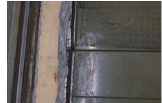
Detail: Rückseite horizontale Elementfuge geöffnet
