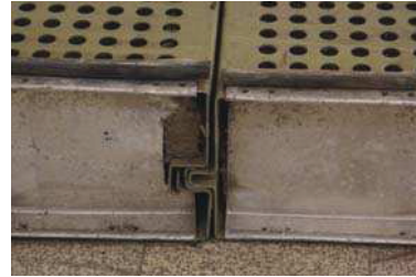
Detail: Nut + Kamm-Verbindung der Elemente
