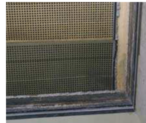
Detail: rückseitig Sickenbleche
