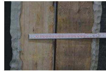
Detail-Ansichten: 10 mm offener Vertikalschlitz zwischen den 2 Stützenhölzern
