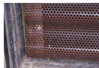
Ansicht-Detail: vorderseitig Alu-Wellblech mit Rundlochung
