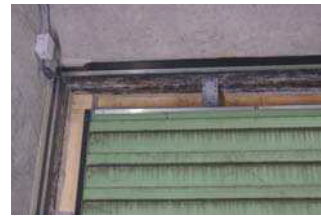
Detail: rückseitig Trapezbleche
