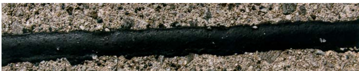
Abbildung 8.3.34: FM6. 5 Jahre nach dem Einbau. Aussehen der Fuge am Objekt
