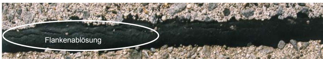
Abbildung 8.3.3: FM1. 5 Jahre nach dem Einbau. Aussehen der Fuge am Objekt
