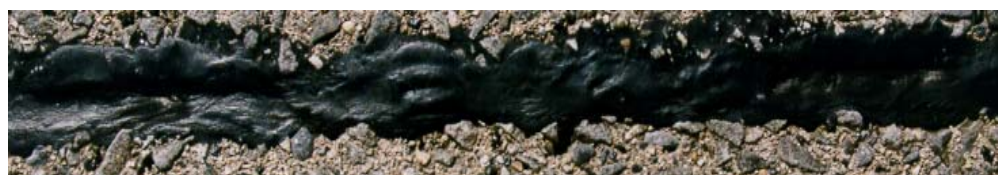
Abbildung 8.3.22: FM4. 5 Jahre nach dem Einbau. Aussehen der Fuge am Objekt
