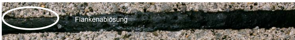
Abbildung 8.3.15: FM3. 5 Jahre nach dem Einbau. Aussehen der Fuge am Objekt
