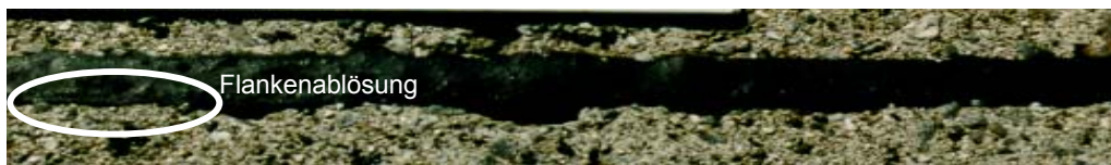
Abbildung 8.3.14: FM3. 2.5 Jahre nach dem Einbau. Aussehen der Fuge am Objekt
