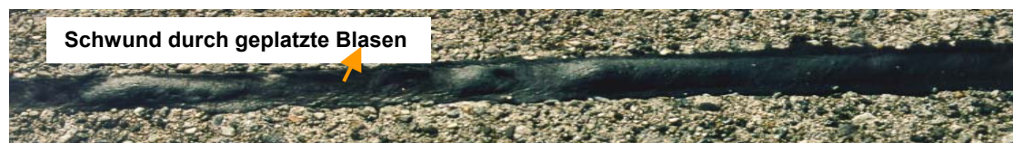
Abbildung 8.3.7: FM2. 1 Jahr nach dem Einbau. Aussehen der Fuge am Objekt
