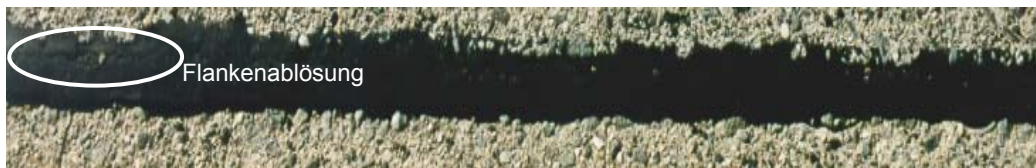
Abbildung 8.3.2: FM1. 2.5 Jahre nach dem Einbau. Aussehen der Fuge am Objekt
