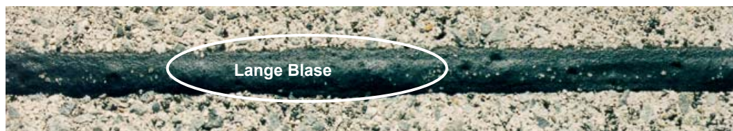
Abbildung 8.3.38: FM7. 1 Jahr nach dem Einbau. Aussehen der Fuge am Objekt
