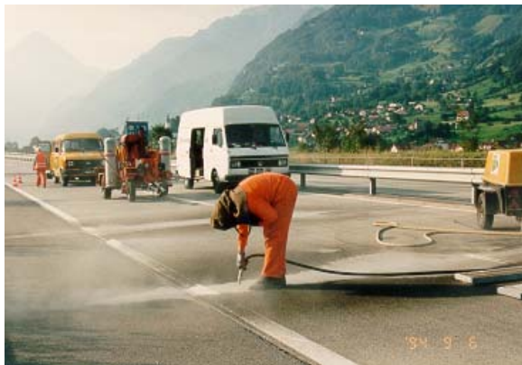
Abbildung 6.2.3: Vorbehandlung der Fuge mit Sandstrahlen
