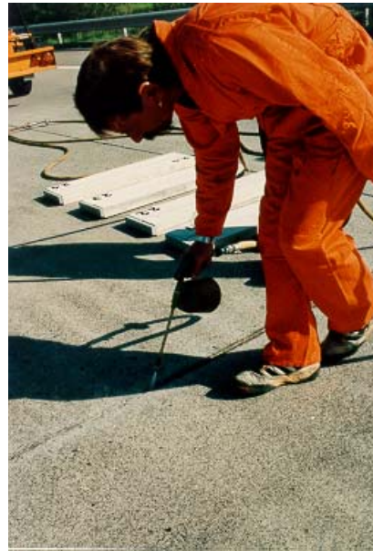
Abbildung 6.2.6: Auftragen des Voranstriches durch Spritzen mit einer Handpumpe
