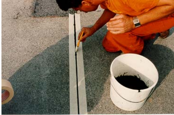
Abbildung 6.2.5: Auftragen des Voranstriches durch Pinseln
