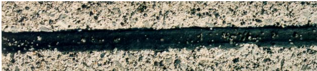
Abbildung 8.3.1: FM1. 1 Jahr nach dem Einbau. Aussehen der Fuge am Objekt. Nach einem Jahr war nur wenig Abstreuerung vorhanden
