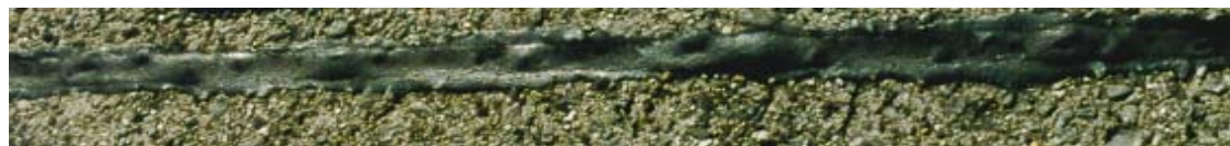
Abbildung 8.3.8: FM2. 2.5 Jahre nach dem Einbau. Aussehen der Fuge am Objekt
