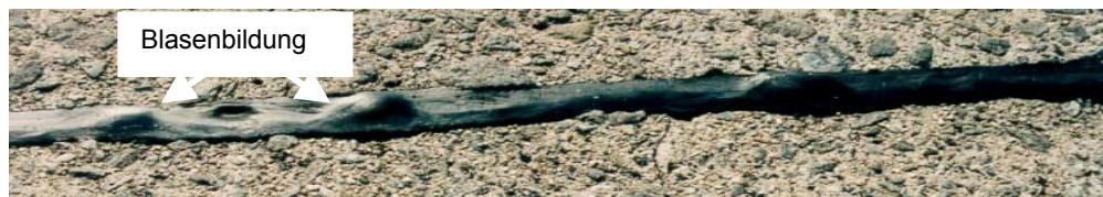
Abbildung 8.3.19: FM4. 1 Jahr nach dem Einbau. Aussehen der Fuge am Objekt
