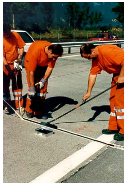
Abbildung 6.2.9: Fugenfüllung mit Giesskübel mit Hilfe eines Gleitschuhs
