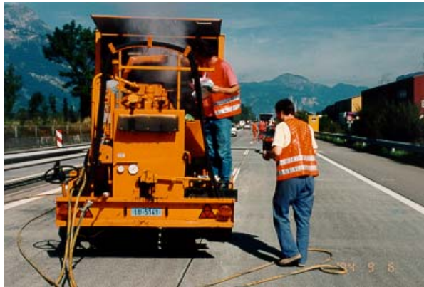
Abbildung 6.2.1: Beispiel eines modernen Kochers mit Ölummantelung, automatischer Temperaturregelung und elektrischem Rührwerk
