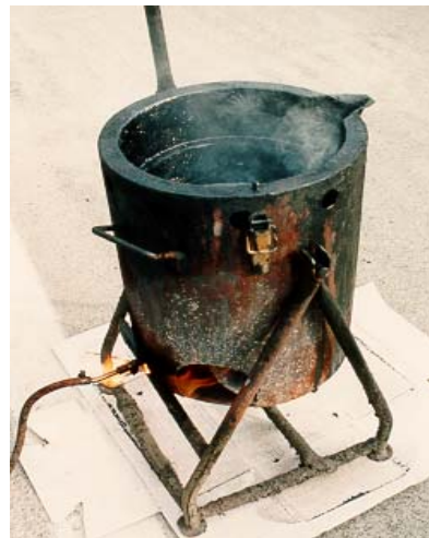
Abbildung 6.2.2: Für den Einbau von FM4 verwendeter Kocher
