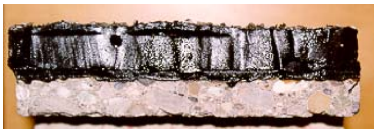
Abbildung 6.4.1: Querschnittsfläche eines Fugenmodellkörpers mit FM3 nach der Zugprüfung gemäss Kap. 8.1. Dieser Fugenmodellkörper wurde parallel zu den Fugen auf der Autobahn unter gleichen Bedingungen eingebaut. Der obere Teil der Fugenvergussmasse zeigt eine Ablösung der zweiten von der ersten Fugenschicht.
