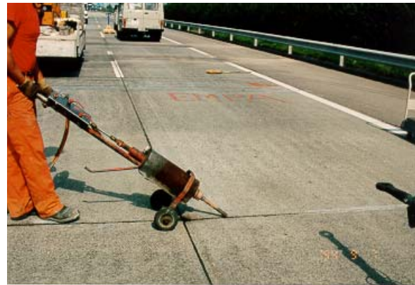
Abbildung 6.2.4: Vorbehandlung der Fuge mit Heisspressluftlanze
