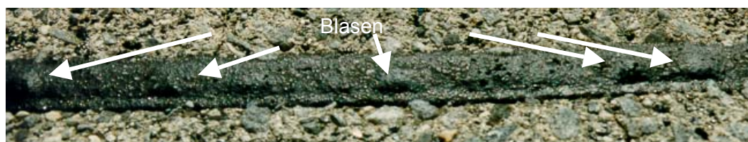
Abbildung 8.3.39: FM7. 2.5 Jahre nach dem Einbau. Aussehen der Fuge am Objekt
