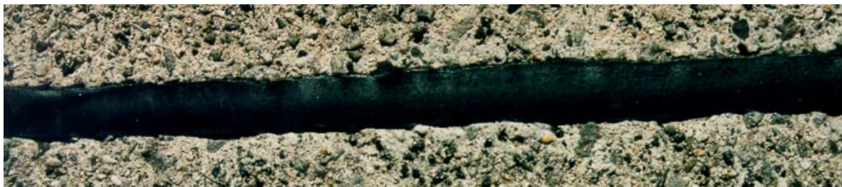
Abbildung 8.3.32: FM6. 1 Jahr nach dem Einbau. Aussehen der Fuge am Objekt
