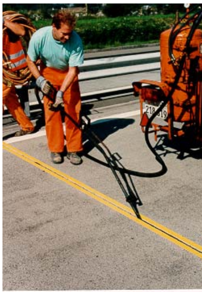
Abbildung 6.2.8: Fugenfüllung mit Lanze
