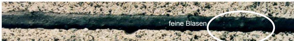
Abbildung 8.3.13: FM3. 1 Jahr nach dem Einbau. Aussehen der Fuge am Objekt
