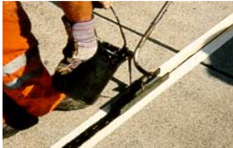
Abbildung 6.3.1: Fugenfüllung mit Gleitschuh
