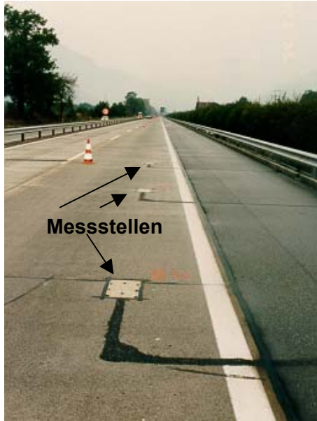
Abbildung 7.1.1: Eingebaute Messstellen auf der Versuchsstrecke
