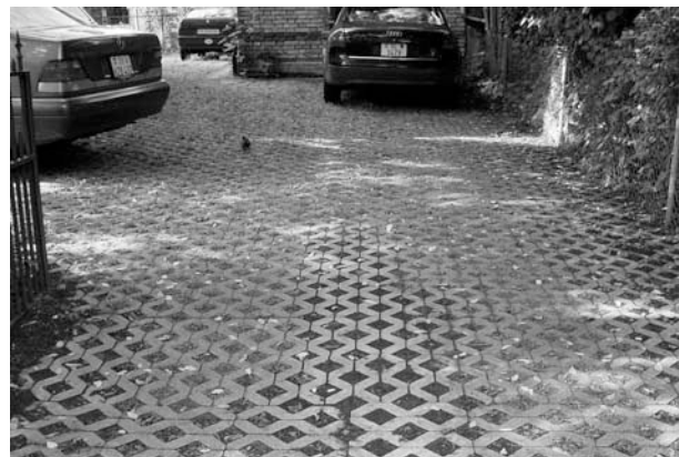
Abbildung 6 Parkplatz mit Rasengitterelementen
