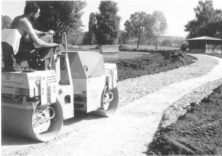
Abbildung 3.3 Einbau der Fundationschicht auf der Teststrecke
