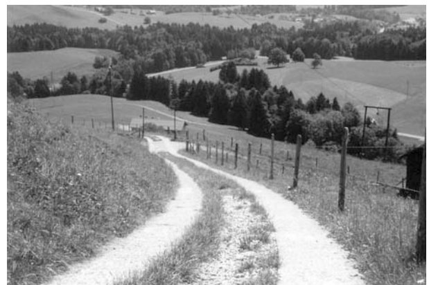
Abbildung 4 Güterstrasse ausserorts als Spurstasse mit Fahrspuren aus Beton
