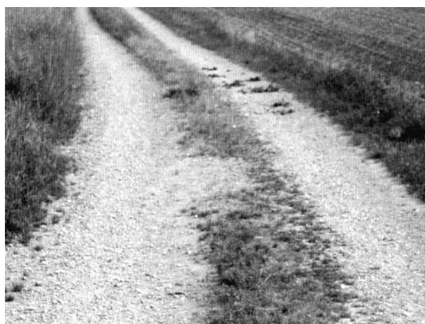
Abbildung 4 Güterstrasse mit Toniger Deckschicht mit Bewuchs zwischen den Fahrspuren
