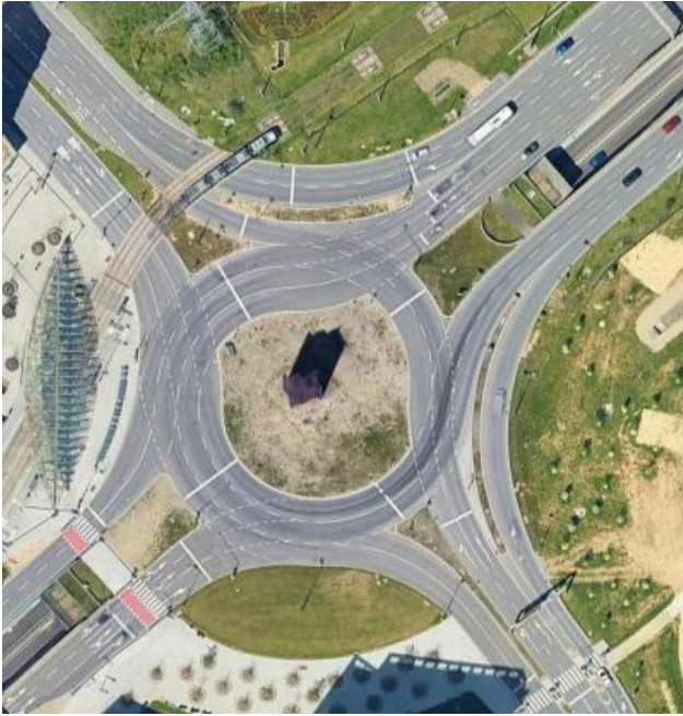
Figure 54: Ligne de tramway parallèle au turbo-giratoire, feux de signalisation sur les branches, Serra (Luxembourg) – Source : google.com/maps .
