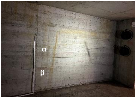
Abbildung 62: Messstelle B an der Rampenbrücke Wiese.
