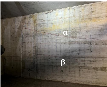
Abbildung 53: Messstelle A an der Rampenbrücke Wiese
