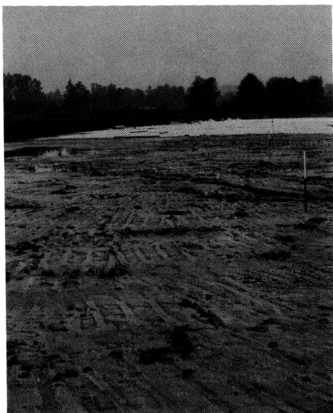
6. Planum im anstehenden Boden, unverdichtet
