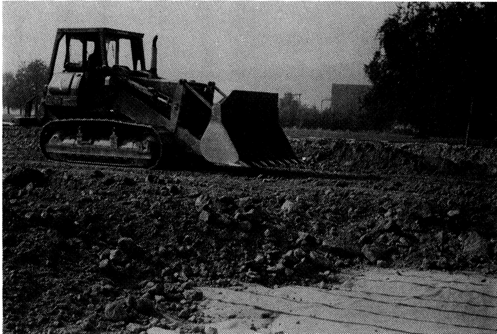
7. Ergänzung des Strassenunterbaus 70 bis 130 cm stark
