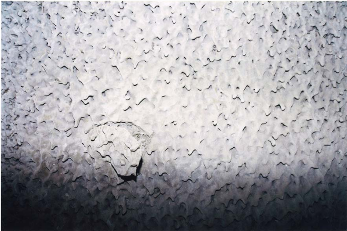
Foto 928/16: PU-Abdichtung mit Tropfenbildung
