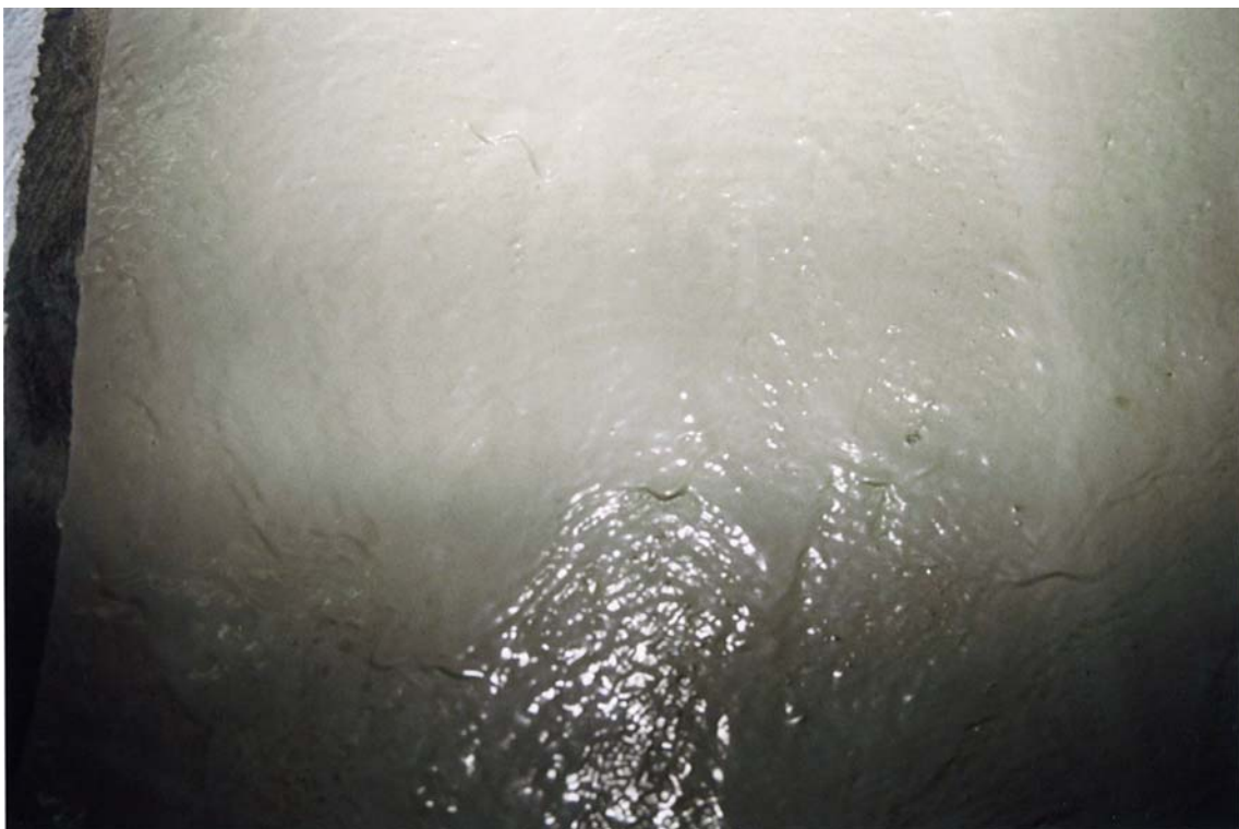
Foto 929/13: Rissüberbrückende Abdichtung
