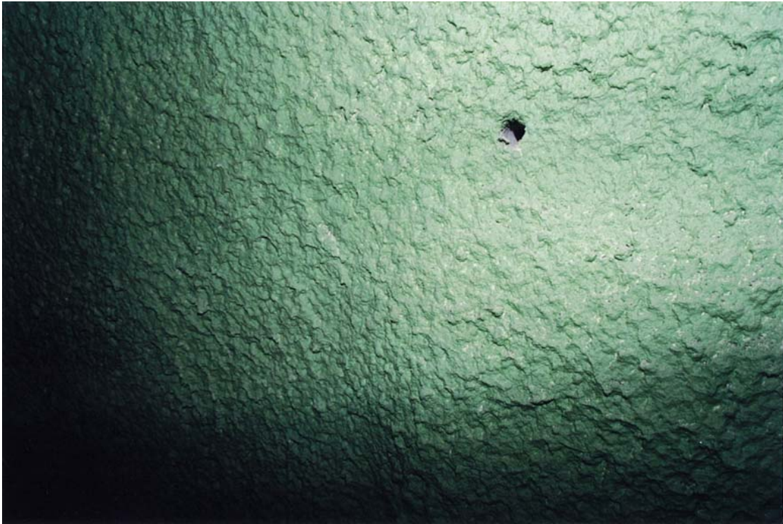
Foto 928/29A: Abdichtung auf Spritzbeton
