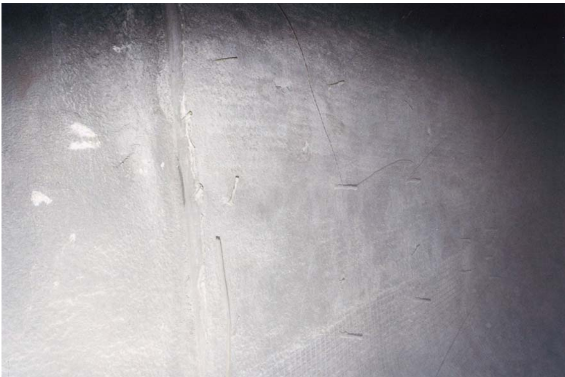
Foto 928/33A: Zementbasierte Abdichtung
