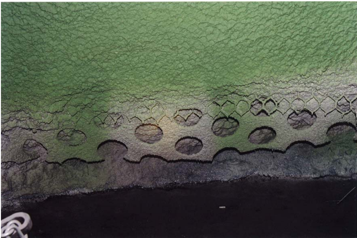
Foto 928/31A: Abdichtung auf Lochvlies
