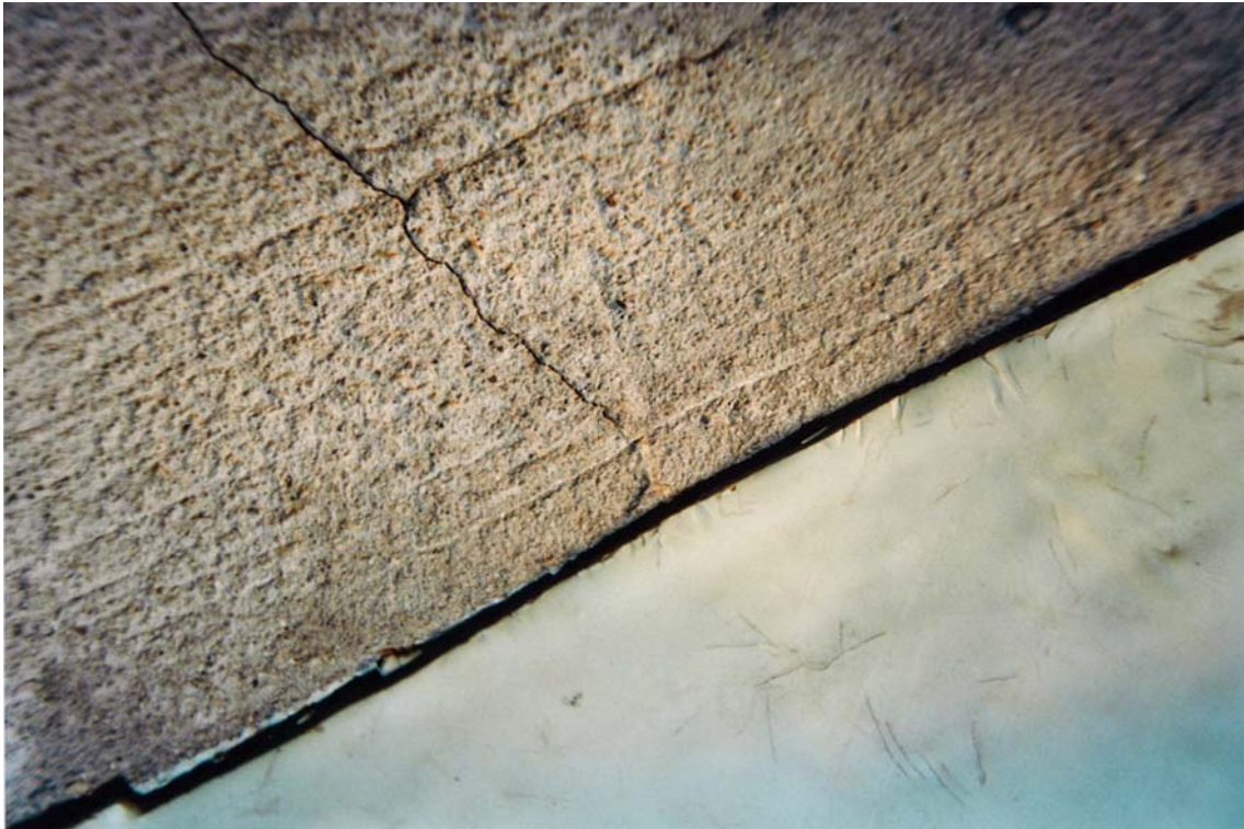
Foto 929/20: Rissüberbrückende Beschichtung
