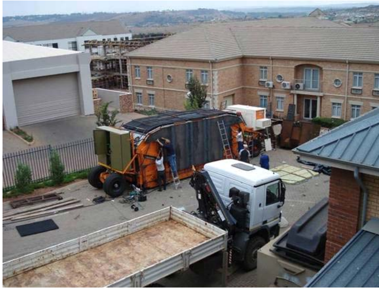
Abb. 4.16 Situationsübersicht mit Werksgebäuden. Die linke Vorderseite der Maschine wird gerade verkleidet. Die Oberseite ist abgedeckt, und vorne am Boden liegt ein Element mit Lärmschutzmatte zur Montage bereit.
