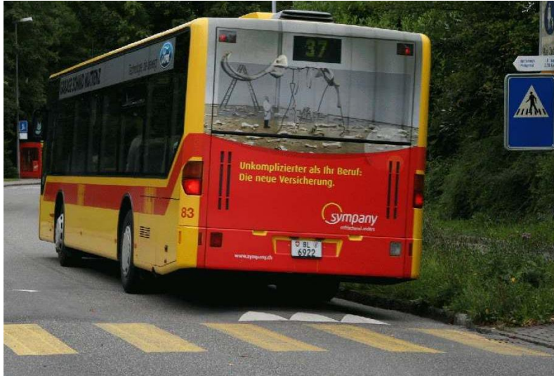
Abbildung 13: Für Busse problemlos passierbare Aufpflasterung 21
