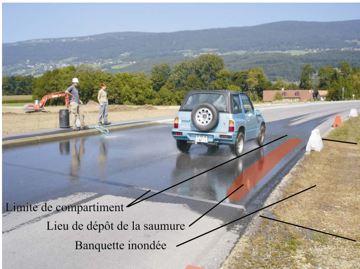
Photo 4.1: Essai no 1 de pluie artificielle. Le procédé d'arrosage sera amélioré pour les essais suivants, permettant une répartition plus homogène sur la route. Arrosage du compartiment conduisant à la banquette gravier-argile, visiblement inondée. Le fût permet de réguliers jaugeages du débit (ici 44.5 l/min).
