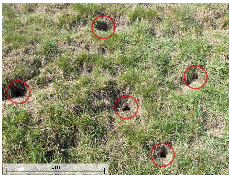
Photo 7.1: Terriers de rongeurs affectant le talus d'infiltration du compartiment SB
