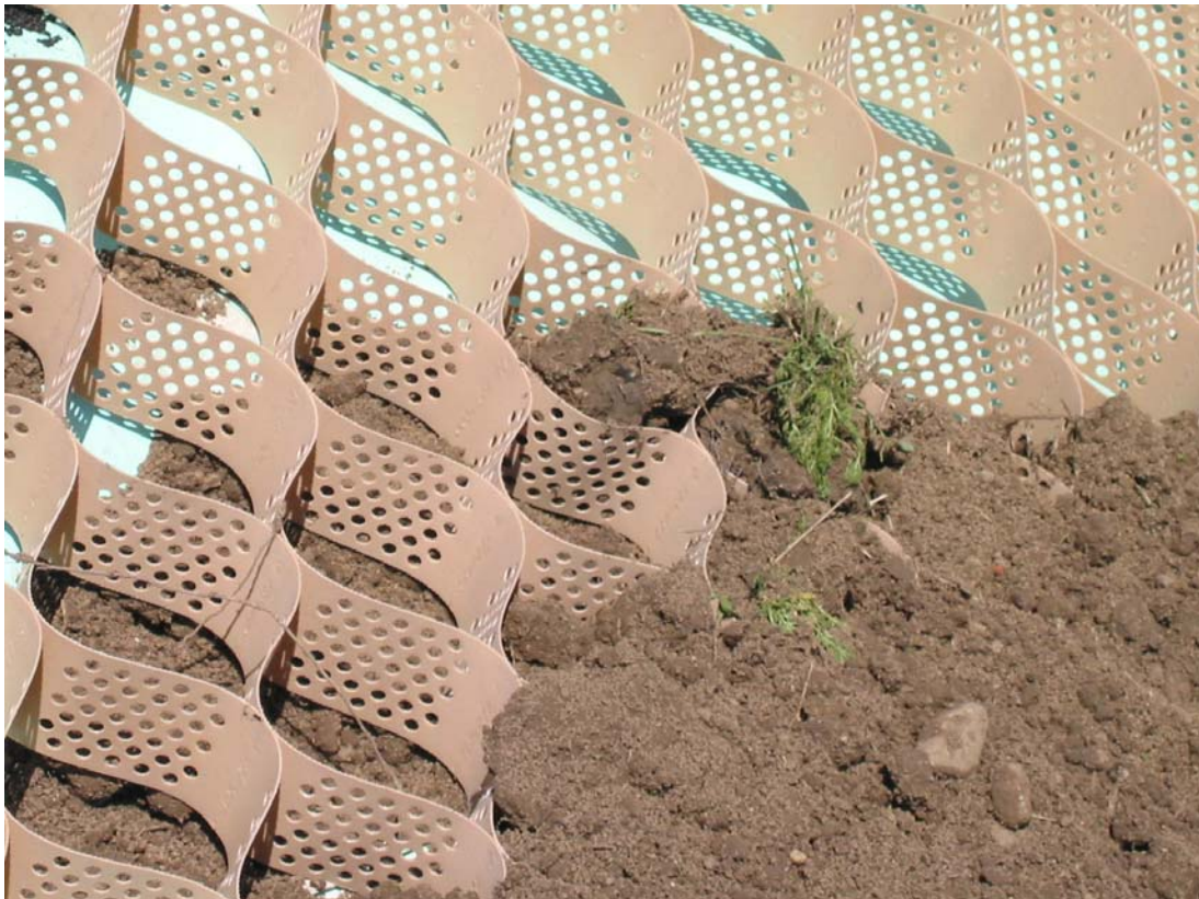
Photo 2.2: profil rugueux « GEOWEB » mis en place pour réduire le risque de glissement du talus sur la géomembrane du fond du lysimètre
