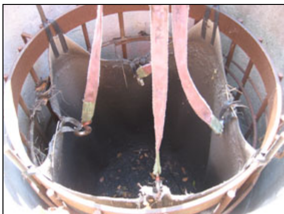
Abbildung 34: Der Geotextilsack wird aus dem Betonschacht herausgezogen und in den Werkhof transportiert für die Entnahme von Schlammproben.
