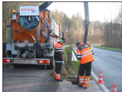
Abbildung 55: Aussaugen des Geotextilsacks mit dem Saugwagen.
