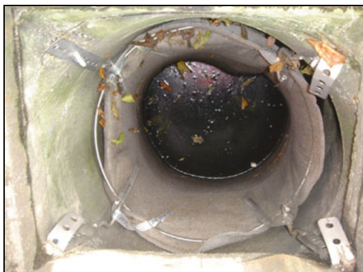
Abbildung 38: Pilotversuch an der Kantonsstrasse Kloten – Lufingen: Der Geotextilsack wird an 4 Einzelhaken aufgehängt und mit einem Spannring nach aussen an die Schachtwand gedrückt.
