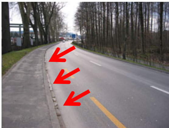
Abbildung 74: Längs des Strassenrandes des Einzugsgebietes des Versickerungsschachtes 1 sammeln sich grosse Mengen an Feststoffen an, die mit dem Regen in den Schacht abgeschwemmt werden.
