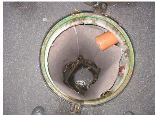
Abbildung 24 : Blick in den Strassenabwasser-Filter schacht mit Geotextilsack.
