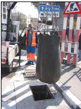
Abbildung 151: Der Sack hängt am Kran und entleert sich langsam.
