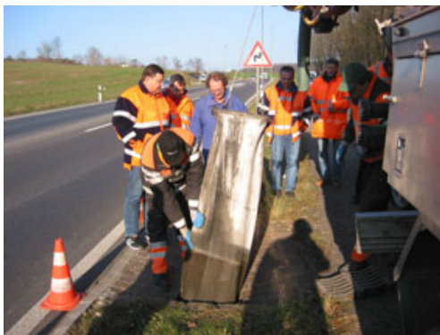
Abbildung 54: Entnahme des Geotextilsacks mit dem Saugwagen.
