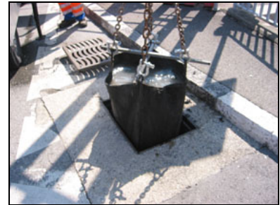
Abbildung 150: Der Sack wird mit dem Kran aus dem Schacht gehoben.
