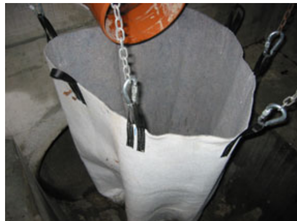
Abbildung 102: Der frisch montierte Geotextilsack.
