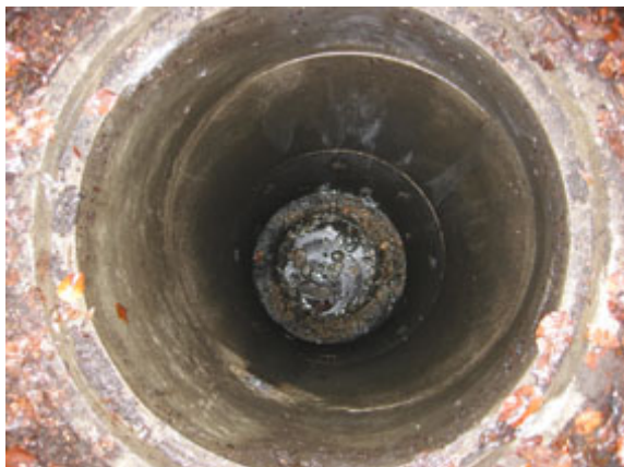
Abbildung 44: Versickerungsschacht Nr. 1 vor dem Einsetzen des Geotextilsacks
