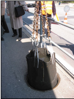
Abbildung 146: Mit dem Kran wird der Sack aus dem Schacht gehoben.
