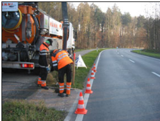
Abbildung 16: Die Strassensammler der Lufingerstrasse entwässern über eine Sammelleitung direkt in den Buehalmbach. In einem Versuch zusammen mit dem Tiefbauamt des Kantons Zürich wurden die Strassensammler mit Geotextilfiltersäcken ausgerüstet.
