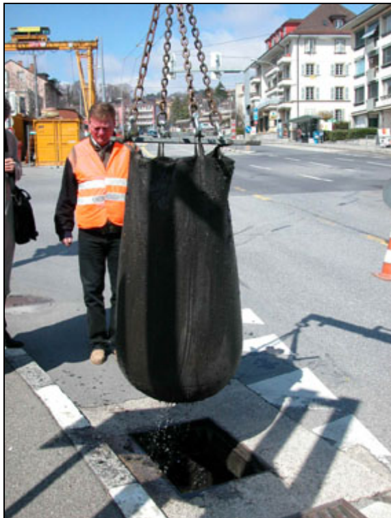
Abbildung 138: Entnahme des Geotextilsacks
