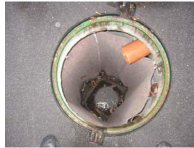
Abbildung 155 : Blick in den Strassenabwasser-Filterschacht mit dem Geotextilsack und der Zuflussleitung.
