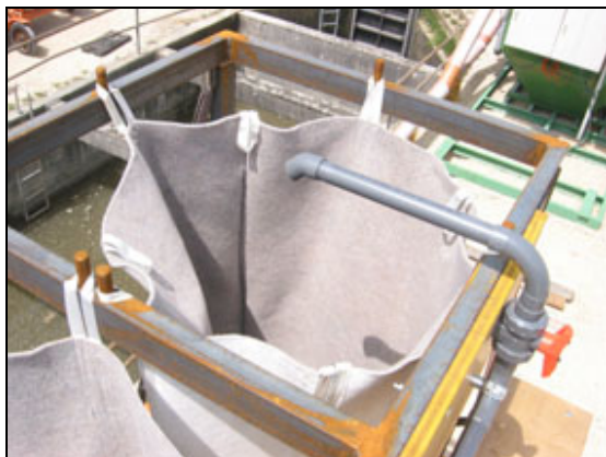
Abbildung 41: Pilotversuche zur Eindickung des Spülwassers aus dem Mecana-Scheibenfilter im Anschluss Wangen a.A. der Autobahn A1. Der Geotextilsack ist oben mit 8 Schlaufen ausgerüstet.
