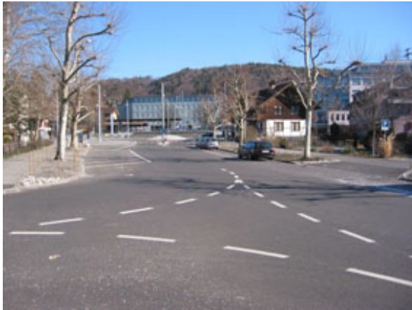
Abbildung 98: Die Moosstrasse. Im Hintergrund der Kreisel Worbstrasse / Moosstrasse.
