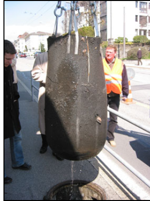
Abbildung 147: Der Sack hängt an 4 Schlaufen. Pro Minute fließen etwa 3 Liter Wasser aus dem Sack.
