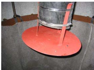
Abbildung 35a: Einbau eines Pralltellers am 19.3.08.
