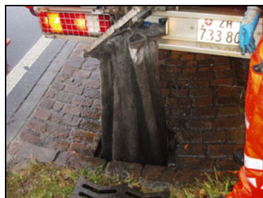
Abbildung 168: Der Sack wird aus dem Einlaufschacht herausgezogen.
