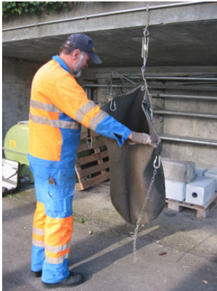
Abbildung 119: Mit einer Federwaage werden die Geotextilsäcke gewogen.
