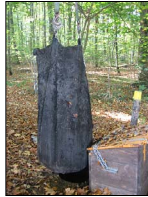
Abbildung 22: Entnahme des Sacks. Mit einem Lastwagenkran wurde der Sack mit dem gesamten Inhalt aus dem Versickerungsschacht herausgezogen.
