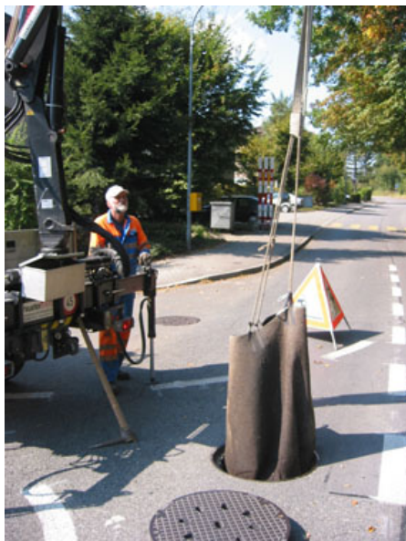
Abbildung 117: Entnahme des Geotextilsacks im Dennigkofenweg.
