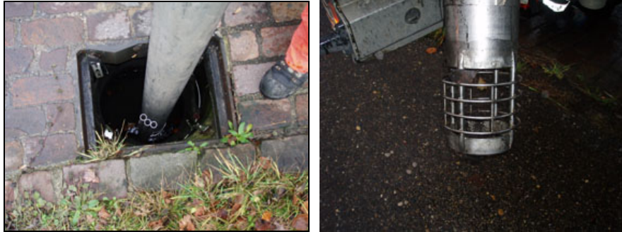
Abbildungen 52 und 53: Pilotversuch an der Kantonsstrasse Kloten – Lufingen, vorne auf dem Saugschlauch des Saugwagens wurde ein kleiner Seiher montiert. Damit konnte der Sack ideal ausgesaugt werden, ohne dass der Sack vom Saugwagen angesogen wurde.
