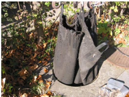
Abbildung 97: Der Geotextilsack wird aus dem Einlaufschacht herausgezogen und in den Werkhof transportiert zum Wägen des Sackinhalts und zur Entnahme der Schlammproben.
