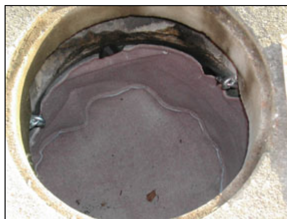
Abbildung 82: Einbau des Geotextilsackes in den Einlaufschacht.
