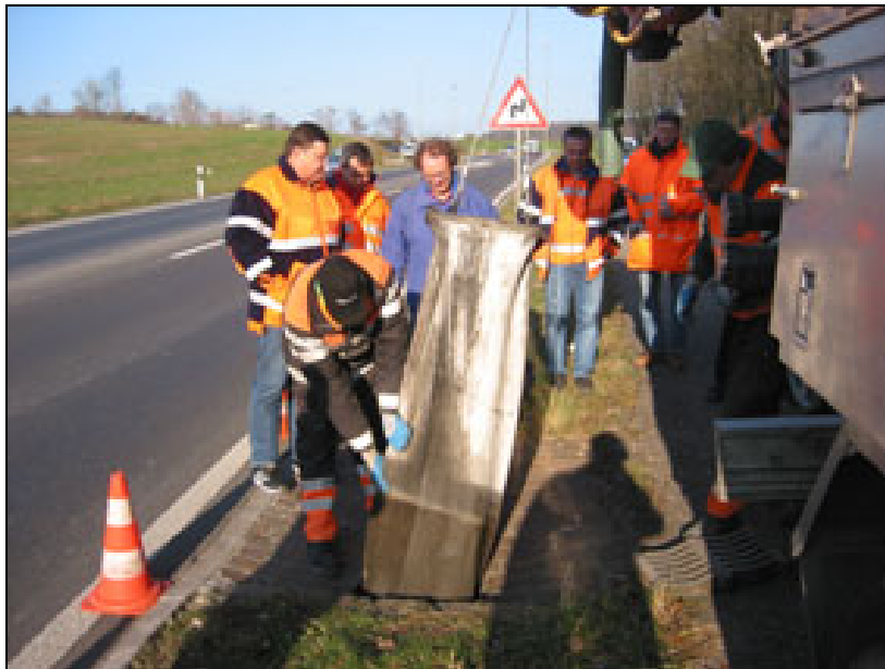
Abbildung 158: Entnahme des Geotextilsacks am 20.12.06
