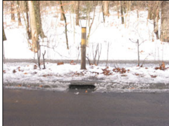
Abbildung 41: Einlauf in den Schlammsammler. In 8 m Entfernung befindet sich der Versickerungsschacht.
