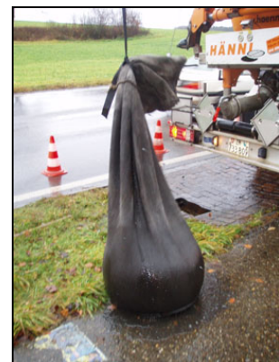
Abbildung 169: Der Sack ist bereit für den Abtransport in den Werkhof. Dort wird er getrocknet.
