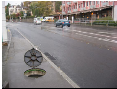
Abbildung 154: Einer der neu erstellten Strassenabwasser-Filterschächte auf der Avenue de Lavaux. Das Strassenabwasser wird vom Strasseneinlaufschacht zum Filterschacht geleitet.
