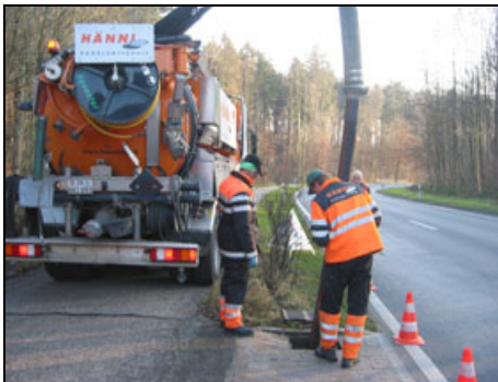
Abbildung 165: Aussaugen des Sackes, ohne dass der Geotextilsack aus dem Einlaufschacht entnommen wird.
