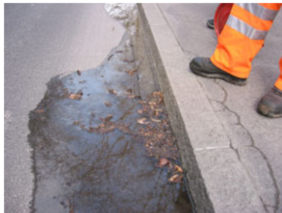
Abbildung 75: Auf dem Bild sind die grossen Laub- und Schlamm-mengen sehr deutlich zu sehen.
