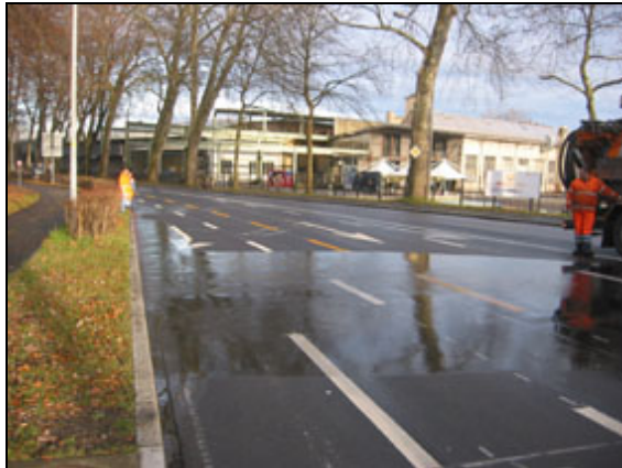
Abbildung 79: Das aus dem Saugwagen ausfließende Wasser fließt zum Einlaufschacht.
