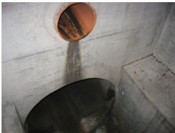
Abbildung 101: Der Kontrollschacht mit der oben in den Schacht einmündenden Strassenent-
