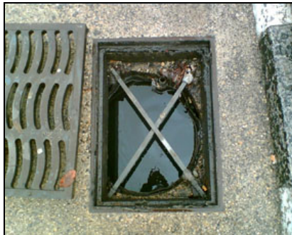
Abbildung 142: Die Installation Lavaux 42. Der Geotextilsack wurde direkt in den Einlaufschacht eingehängt.
