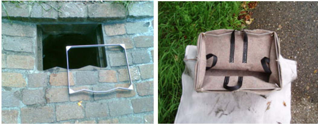
Abbildung 39: a) Pilotversuch an der Kantonsstrasse Kloten – Lufingen: der Einlauf des Schlammsammlers mit dem Rahmen und b) Geotextilsack mit eingepasstem Rahmen, fertig für den Einbau.
