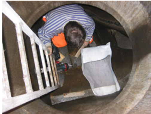
Abbildung 125: Der Geotextilsack wurde horizontal in den Kontrollschacht eingebaut.
