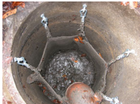
Abbildung 45: Aufhängung des Geotextilsacks mit Schrauben und Ketten
