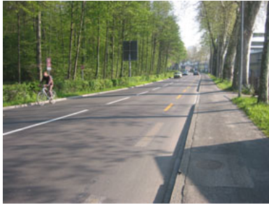
Abbildung 20: Das Strassenabwasser der Bremgartenstrasse in Bern wird mit Versickerungsschächten in den Boden eingeleitet.
