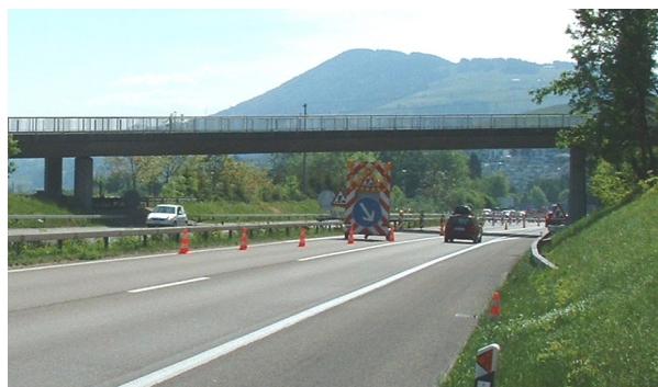
Abbildung 18: Beispiel einer zusätzlichen Absicherung der Signalwand mit Leitkegeln
