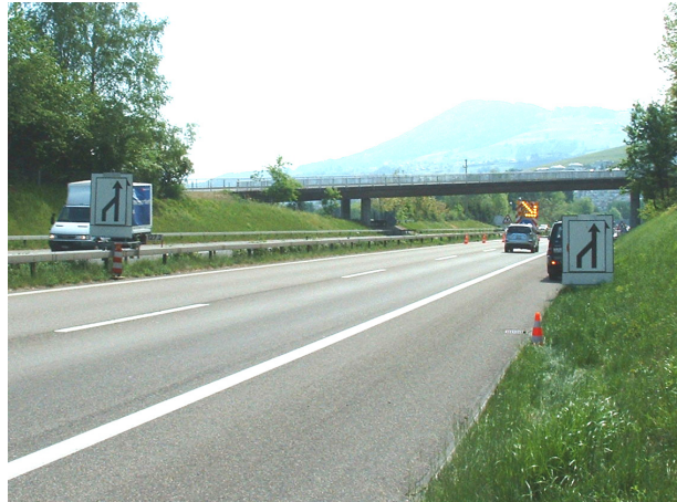
Abbildung 14: Zusatzsignal bei neuer Versuchsanordnung an der Tagesbaustelle A3-Wolerau (Abbau des Überholstreifens)
