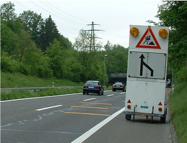
Abbildung 13: Zusatzsignal bei neuer Versuchsanordnung an der Tagesbaustelle A53-Uster (Abbau des Normalstreifens)
