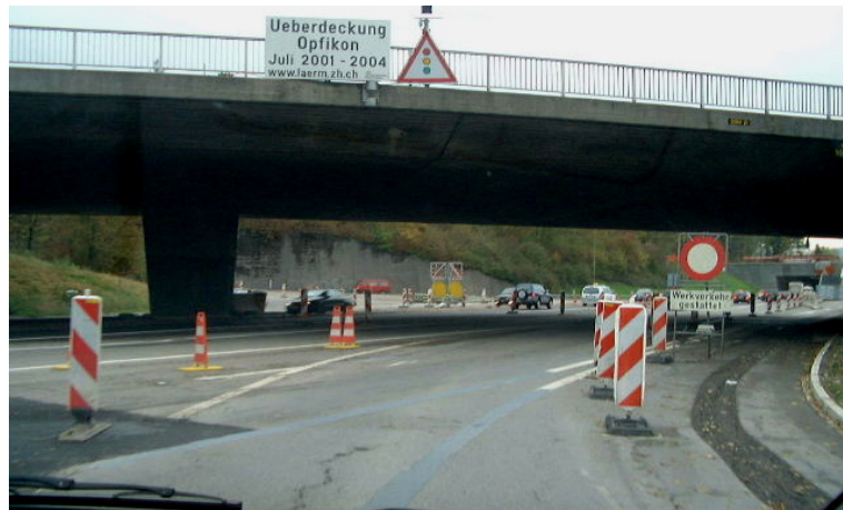
Abbildung 28: Sicht in der Einfahrt auf den Beschleunigungsstreifen bei der Untersuchungsstelle 8
