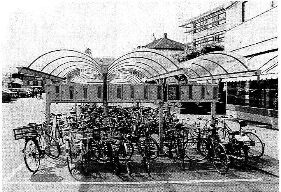
Abb. 1-2: Hier wurde eine Zweiradabstellanlage mit einer teuren Überdachung sowie mit Schliessfächern ausgerüstet, dafür ein untaugliches Abstellsystem eingesetzt: Mangels Entscheidungsgrundlagen wurde teilweise an den wichtigsten Anforderungen der Benutzer vorbeiprojiziert.
