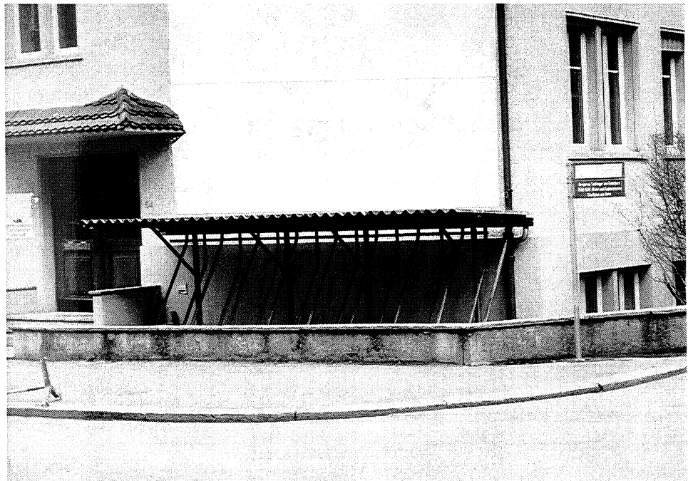
Abb. 2-10: Städtebaulich unbefriedigende Zweiradabstellanlage
