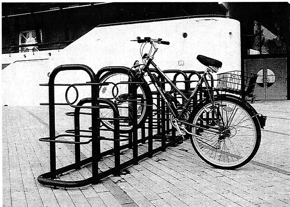
Abb. 4-8: Anlehnbügel im Vorderradbereich
