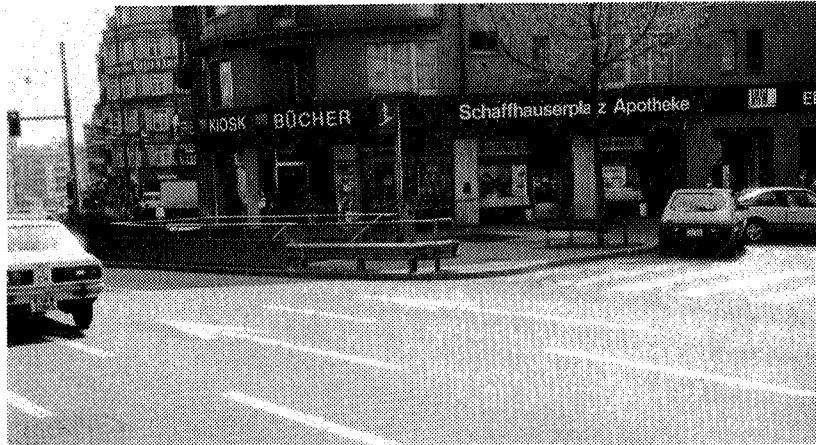
Abb. 6-1, Leitschranke beim Abgang zu einer Personenunterführung
