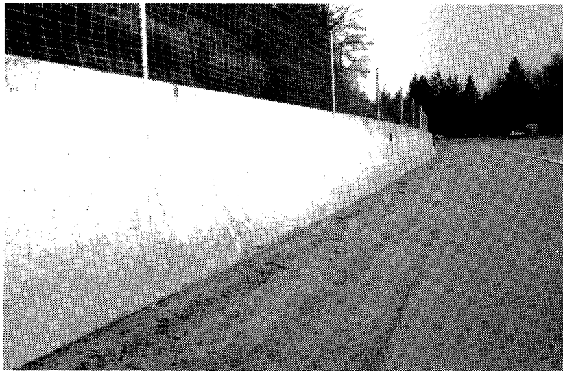
Abb. 5-8, Beispiel einer günstigen Profilierung eines Mauerfusses
