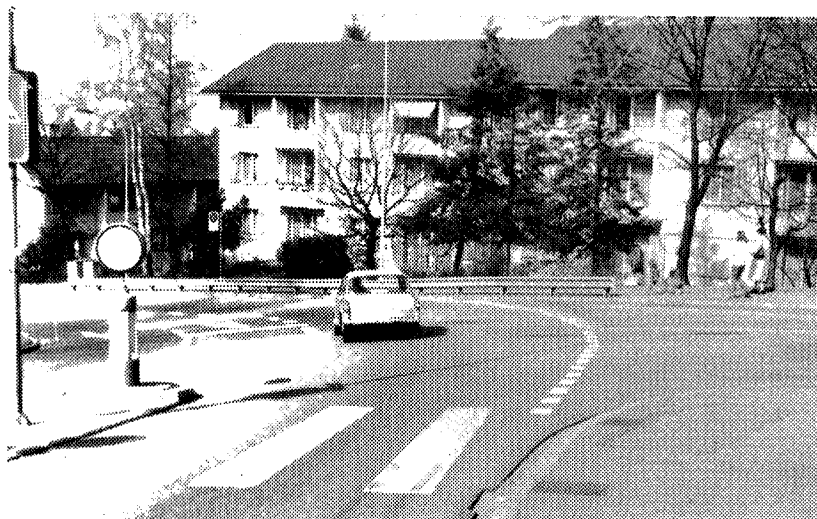
Abb. 6-2, Leitschranke an einer Stelle mit einer hohen Abirrwahrscheinlichkeit
