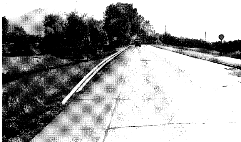
Abb. 7-8, Leitschrankenanzug abgesenkt auf Damm
