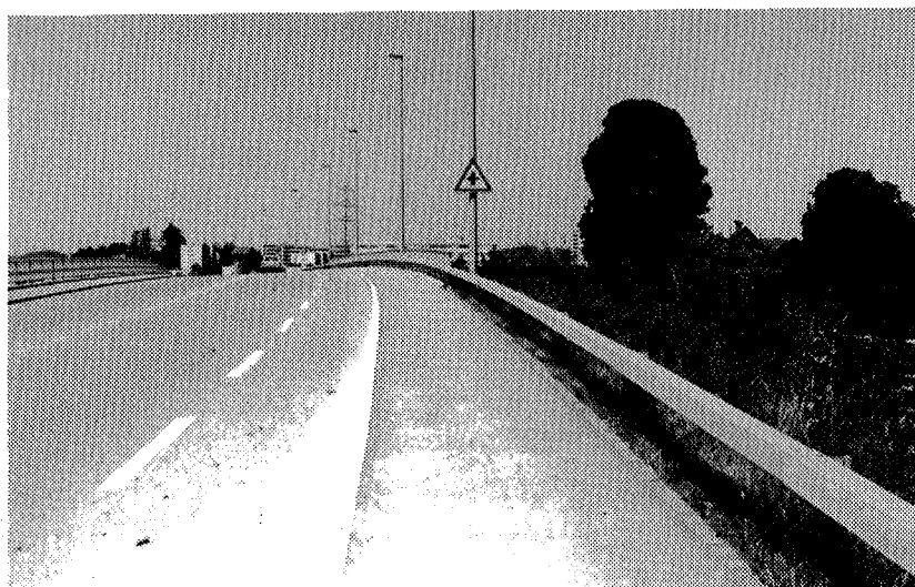
Abb. 7-2, Leitschranke mit genügender Länge
