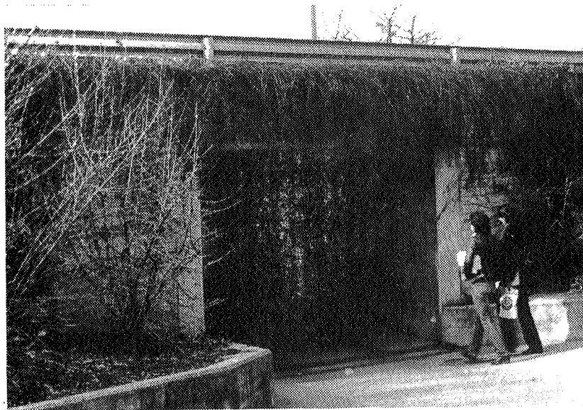
Abb. 5-19, Leitschranke zum Schutz des Zuganges zu einer Personenunterführung
