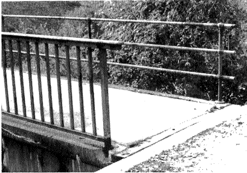
Abb. 2-6, Staketengeländer (links) und Gasrohrgeländer (rechts)
