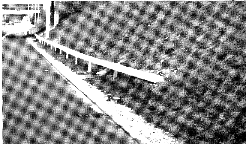
Abb. 7-7, Leitschrankenanzug in die aufsteigende Böschung geführt
