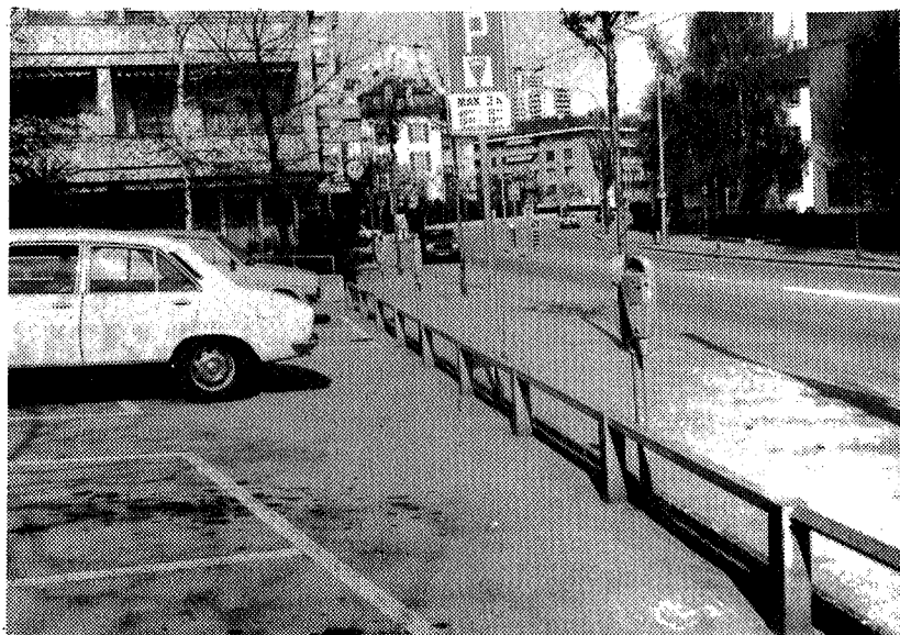
Abb. 6-5, Parkplatzabgrenzungen mit Abschränkung aus schlanken Längselementen
