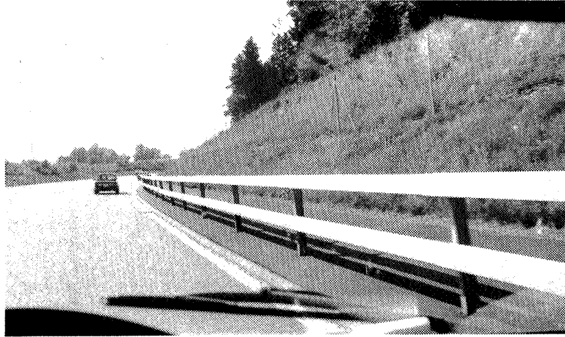
Abb. 5-24, Leitschranke im Gewässerschutzgebiet
