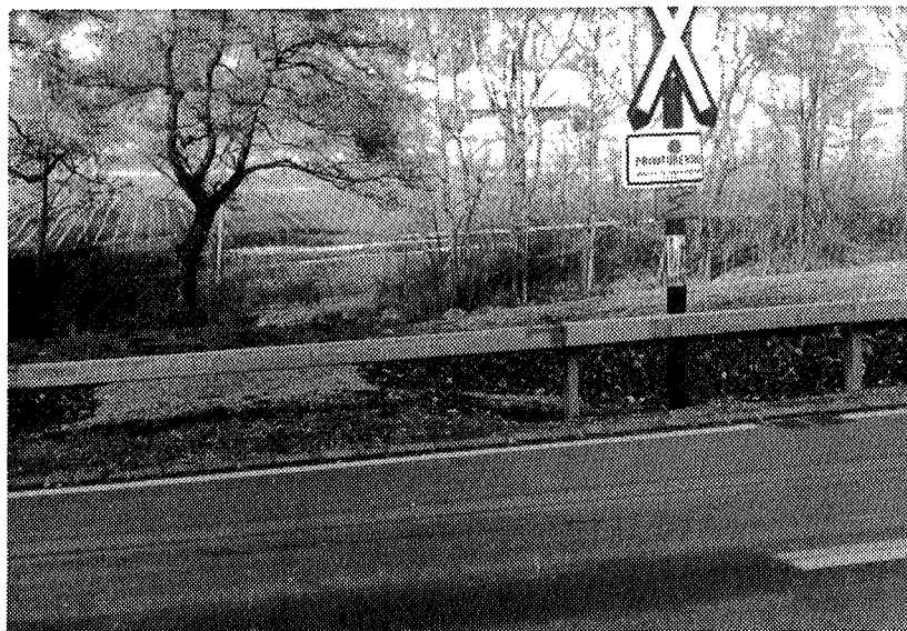
Abb. 7-11, Rasch demontierbare Leitschranke bei einer selten genutzten Zufahrt
