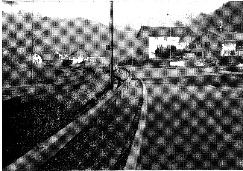
Abb. 5-18, Leitschranke zwischen Strasse und Bahnlinie
