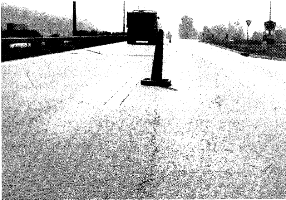
Abb. 16: Typischer Längsriss
