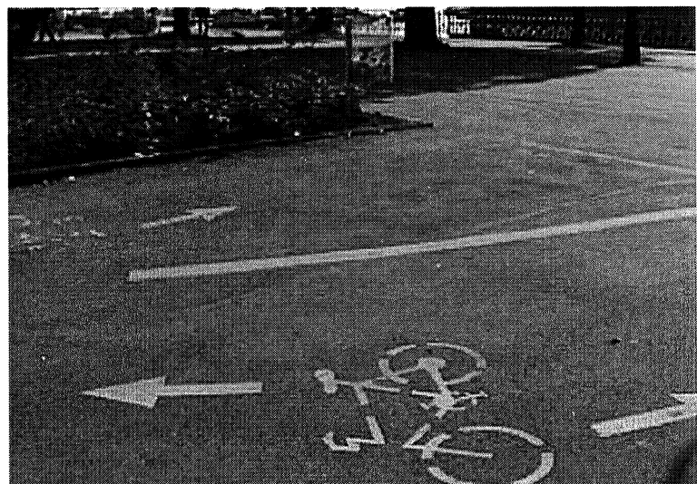
Übermass an Markierung vermeiden
