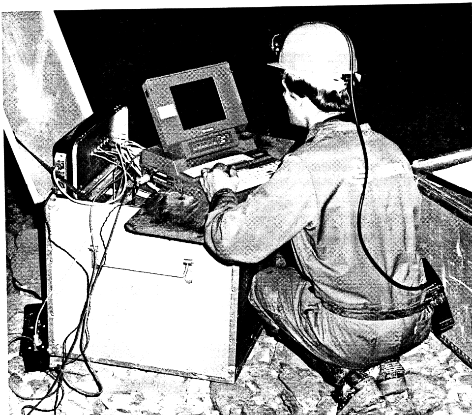
Bild 20 Testmessungen mit Georadar im Umfahrungstunnel von Wattwil Konventionelles Radarsystem RAMAC mit Steuergerät und Computer
