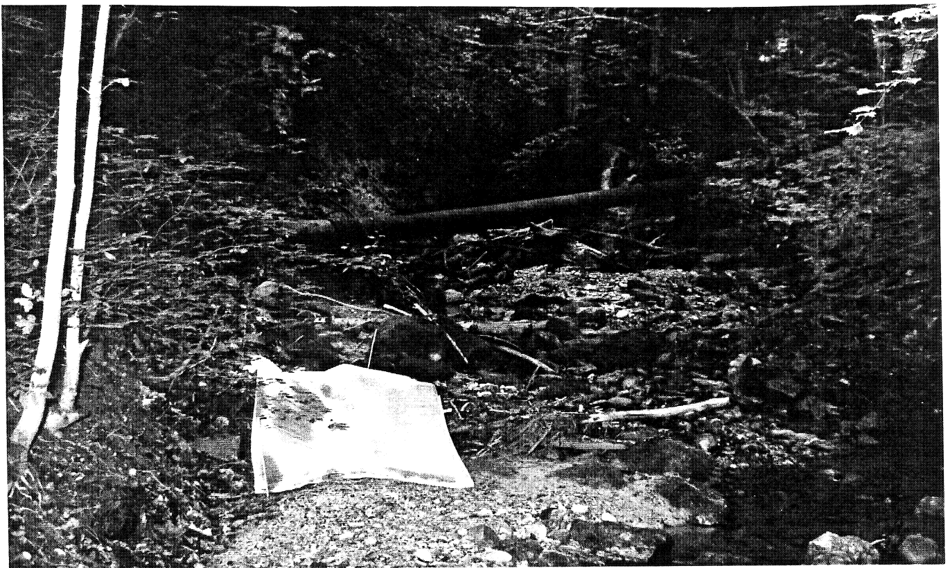
Bild 19 Testmessungen mit Georadar im Umfahrungstunnel Wattwil nach der konventionellen Radarmethode. Künstliche Reflexionshorizonte aus Metallgittern im Hagtobel
