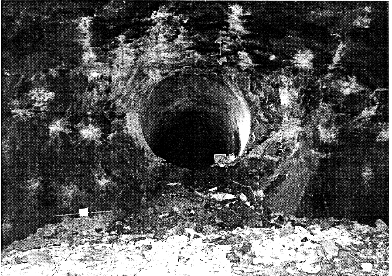
Bild 21 Testmessungen mit Georadar im Umfahrungstunnel Wattwil. Übergangsbereich von der Kalotte in den Pilotstollen. VRP-Messungen zur Ermittlung der Wellenfortpflanzungsgeschwindigkeit
