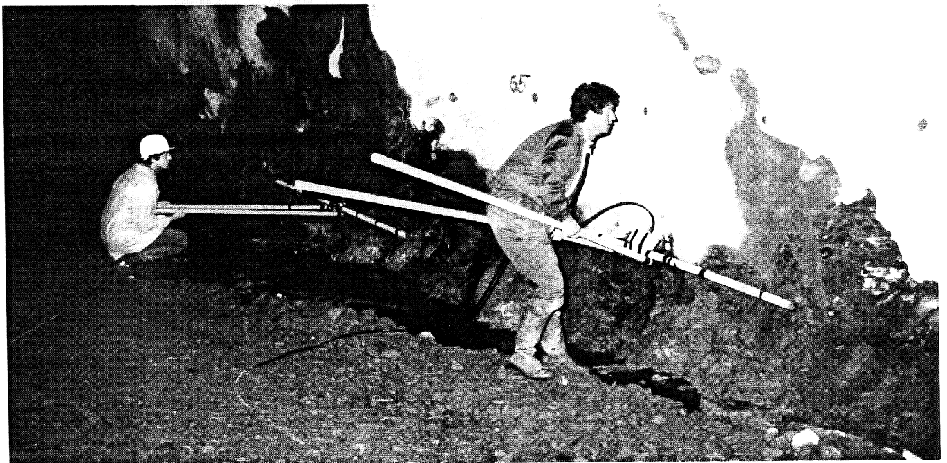
Bild 14 Umfahrungstunnel Leissigen: Testmessungen mit synthetischem Pulsradar
