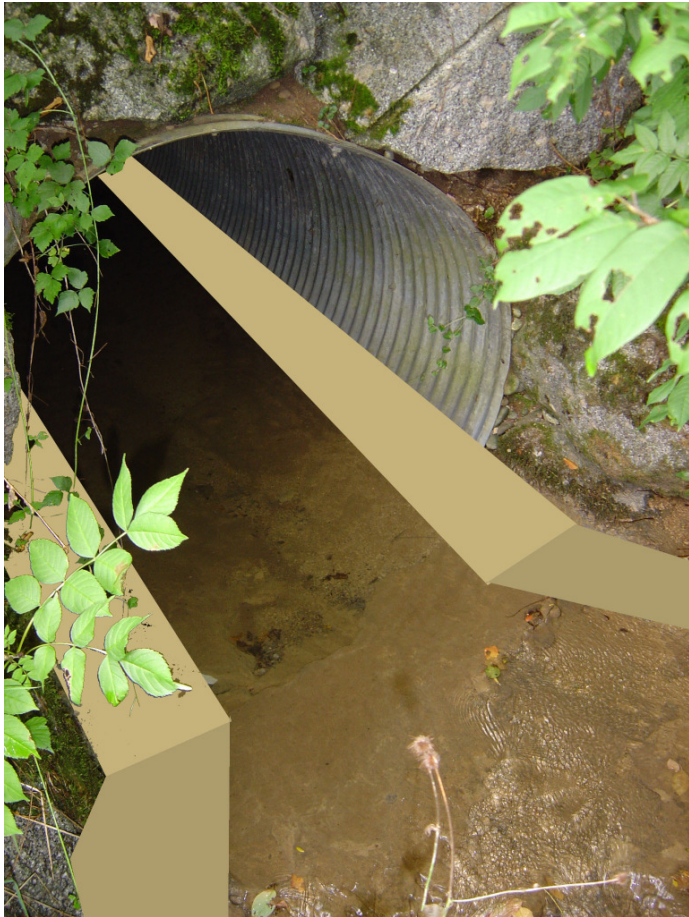
Abbildung 8: Sanierungsvorschlag mit einem 40 cm breiten, beidseitigen Holzbrett
