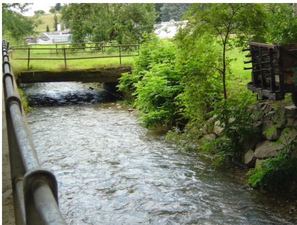
Abbildung 41: Brücke mit Wirtschaftsweg über den Möhlinbach
