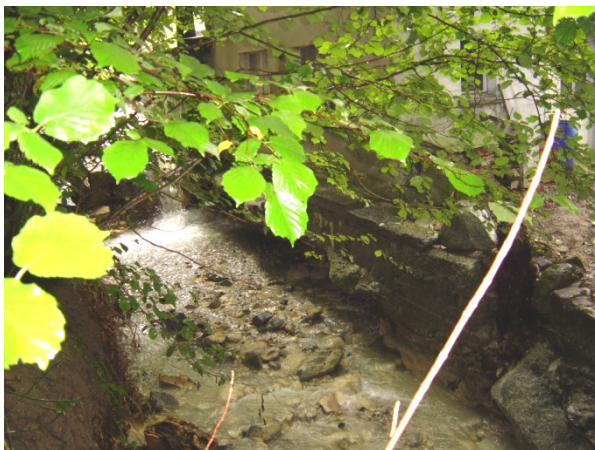
Abbildung 25: Ausgeschwemmte Verbauung
