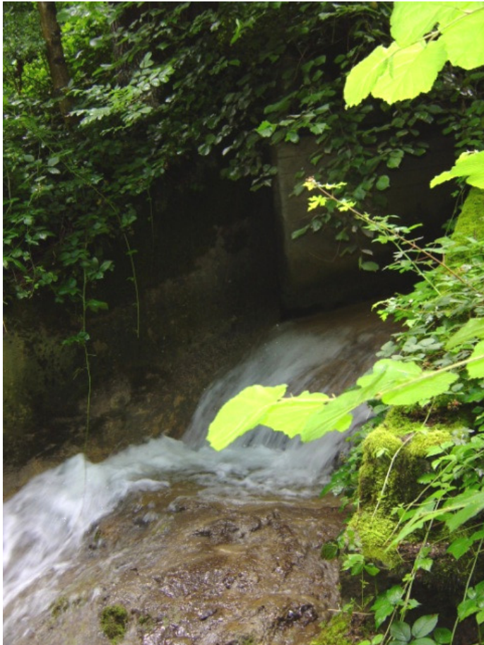
Abbildung 29: Hohe Abstürze unterhalb des Durchlasses
