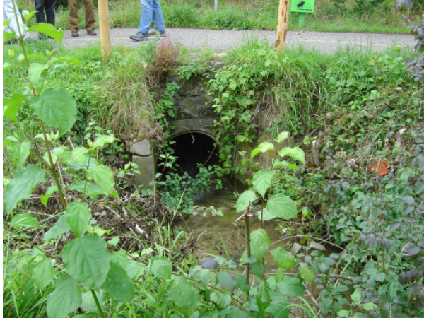
Abbildung 3: Rohrdurchlass eines Seitenbachs der Sissle (alle Fotos im Anhang sind von A. Wegelin, PiU GmbH)
