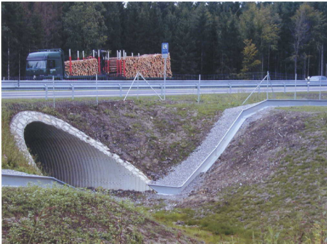
Abbildung 21: Amphibienschutzgitter (aus Bossard + Staerke AG)
