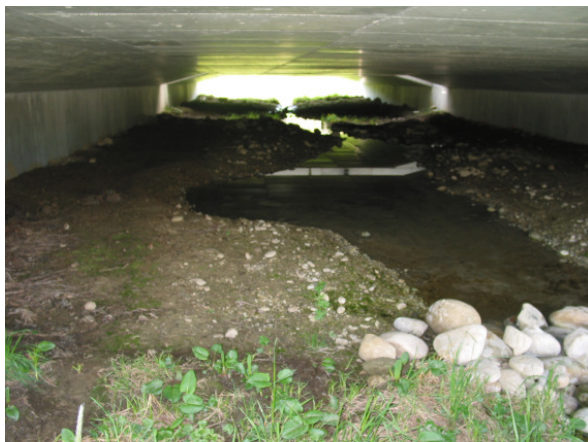
Abbildung 17: Mögliche Ausgestaltung einer Durchlasssanierung für terrestrische Arten – für aquatische Organismen ist der Durchlass rechts nach wie vor ungeeignet (starke Strömung, unnatürliche Sohle). links: Bahn 2000 in Langenthal; rechts: A1 bei Wangen an der Aare. (Fotos S. Zumbach, karch)
