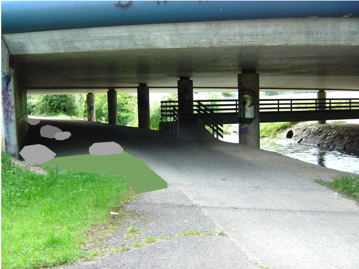
Abbildung 34: Sanierungsvorschlag: Reduzieren des Regenschattens und Platzieren von grösseren Steinen unter der Brücke
