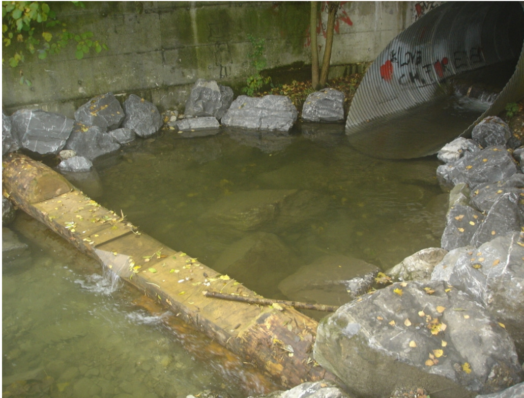
Abbildung 13: Aufwertungen für Fische am Lötchenbach mit vorgelagerten Aufstiegsrampen und Becken sowie „baffles“ im Durchlass (Foto V. Maurer, HYDRA)
