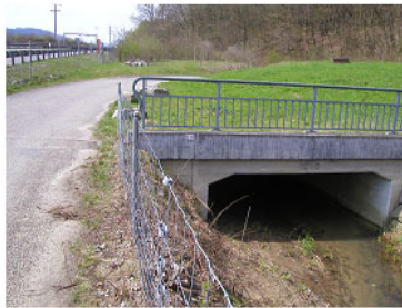
Nicht faunaspezifischer Gewässerdurchlass
