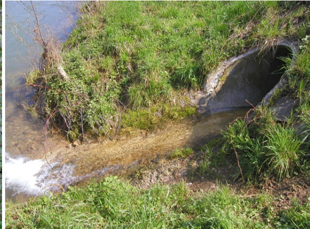
Abbildung 4: Starkes Gefälle zwischen Durchlass und Mündung
