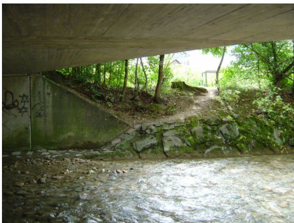
Abbildung 37: Rampe zum Durchlass
