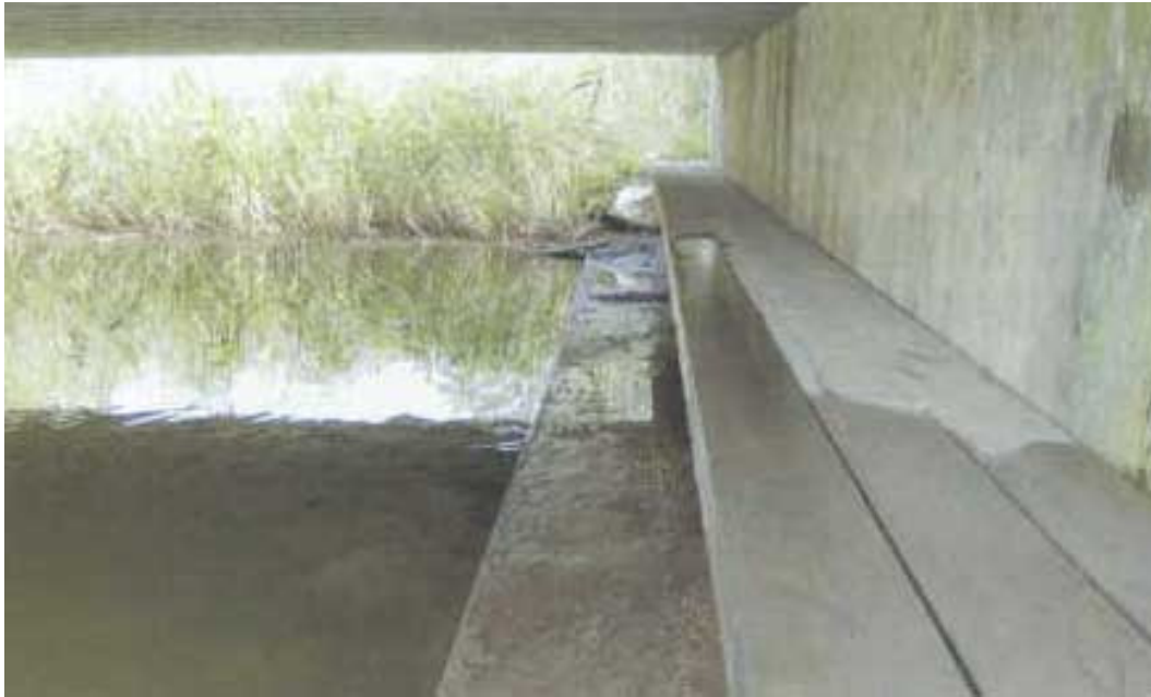
Abbildung 7: Durchlass mit zweistufigen Holzbrettern aufgewertet (Foto F. Navàs)
