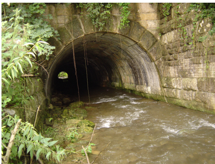
Abbildung 26: Der aufgewertete Staffeleggbach im Kt. AG nach 2 Jahren. Das Bankett weist gewisse Löcher auf, welche die Attraktivität für die terrestrische Fauna verringern
