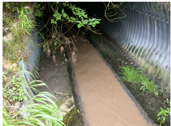
Abbildung 17: Mögliche Ausgestaltung einer Durchlasssanierung für terrestrische Arten – für aquatische Organismen ist der Durchlass rechts nach wie vor ungeeignet (starke Strömung, unnatürliche Sohle). links: Bahn 2000 in Langenthal; rechts: A1 bei Wangen an der Aare. (Fotos S. Zumbach, karch)
