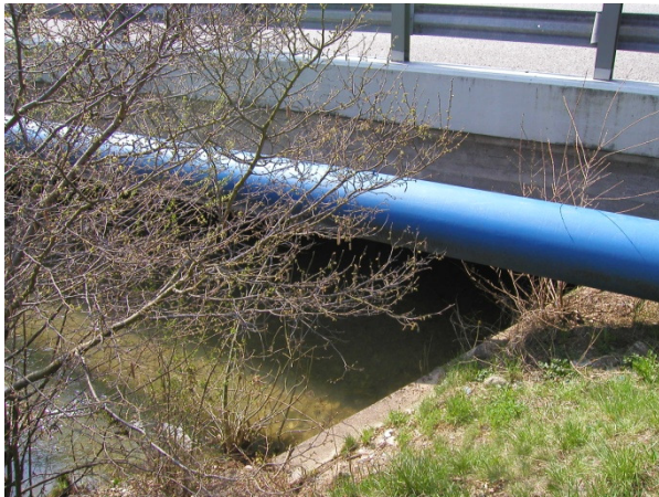
Abbildung 35: Autobahnbrücke über die Sissle
