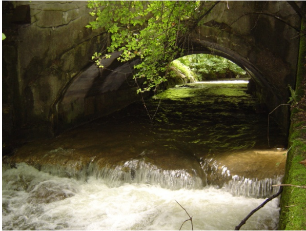
Abbildung 17: Bogendurchlass mit Absturz
