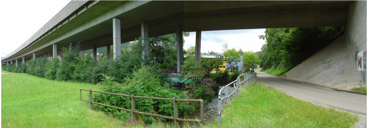
Abbildung 40: Autobahnviadukt bei Zeiningen
