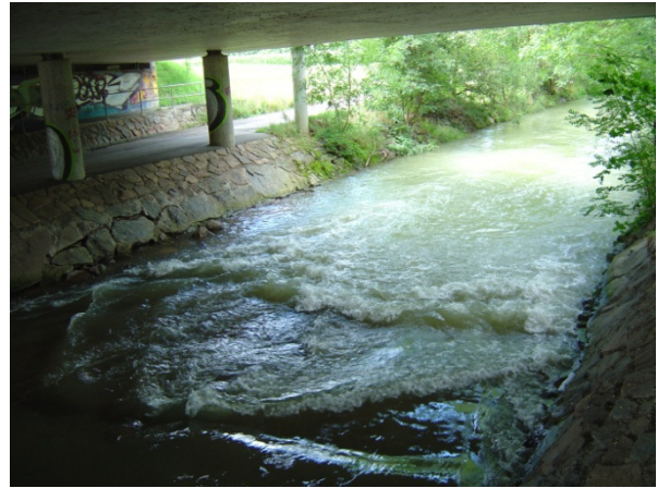
Abbildung 32: Starke Strömung unter der Brücke
