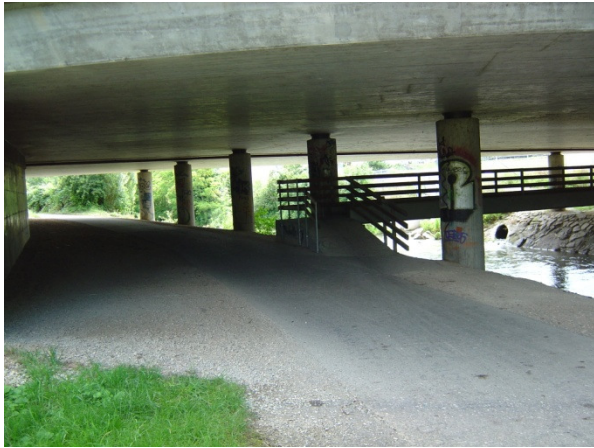
Abbildung 31: Autobahnbrücke über die Sissle bei der ARA
