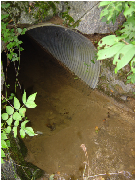
Abbildung 6: Rohrdurchlass
