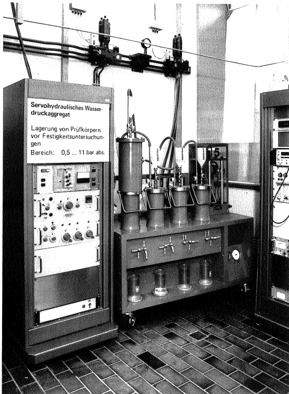
Photo 2: Gesamtansicht der Prüfanlage.
