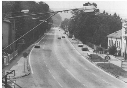
Abb. 64: vor der Umgestaltung
