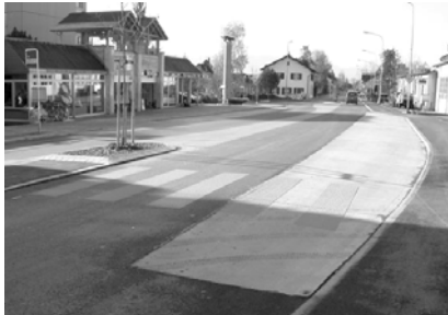
Abb. 12: Bushaltestelle im Bereich des Mehrzweckstreifens
