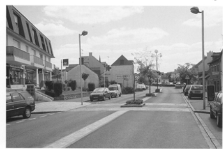
Abb. 68: Querungsstelle für Fussgänger
