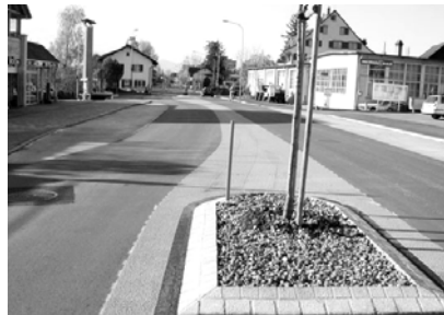
Abb. 13: „geschwungener“ Mehrzweckstreifen im Bereich der Bushaltestelle
