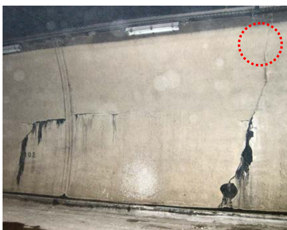
Abbildungen 11 bis 13– punktförmiger Temperaturunterschied im oberen Parament des Arisdorftunnels hinweisend auf eine Leckstelle hinter dem Gewölbe
