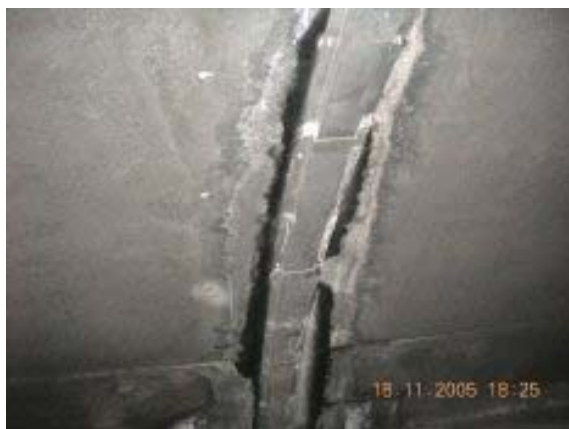
Abbildung 16 und 17 - Wassereintrittsstelle von einer Metallplatte gedeckt im Ventilationskanal des Milchbucktunnels
