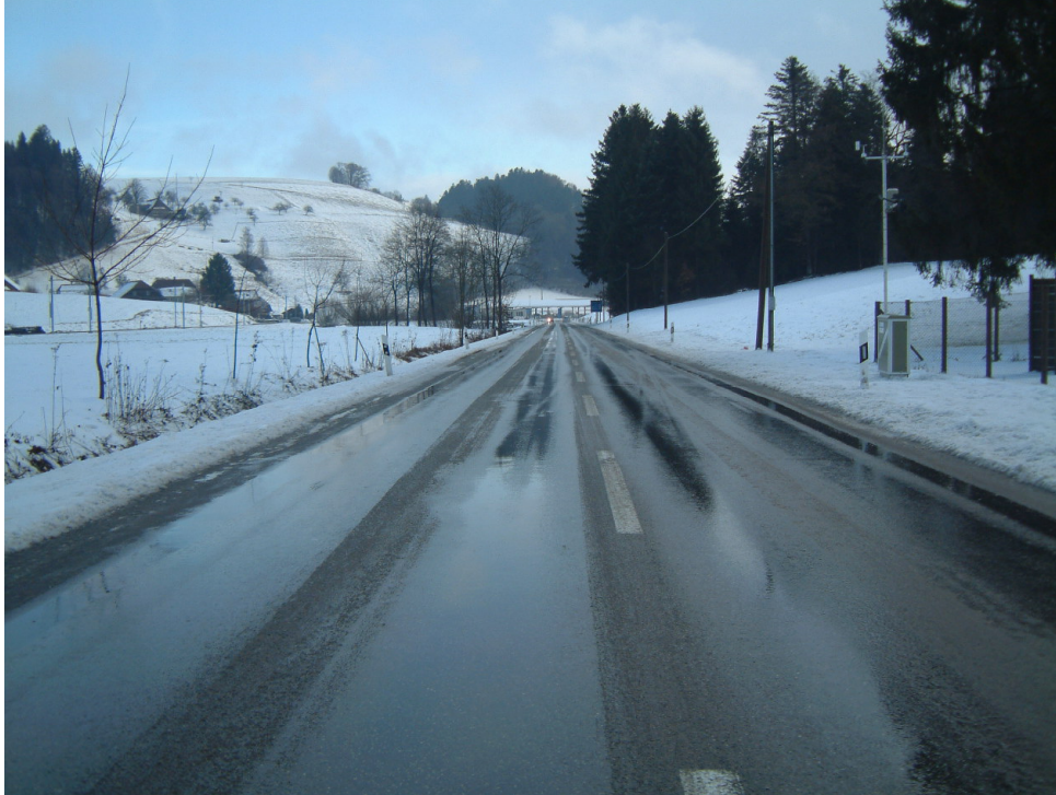
Abbildung 8-7: Zustand einer Kantonsstrasse im Kanton Luzern am kritischen Morgen (nach Eisregen) vom 31.12.2005 (10.55 Uhr)
