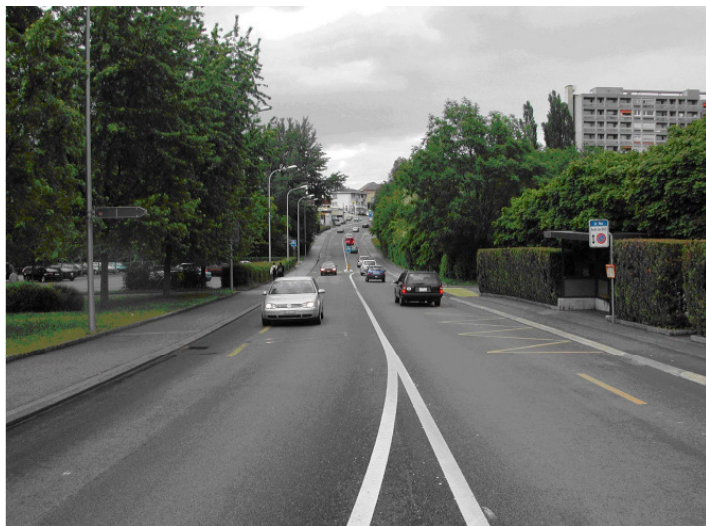
Blickrichtung Route de l' Etraz
