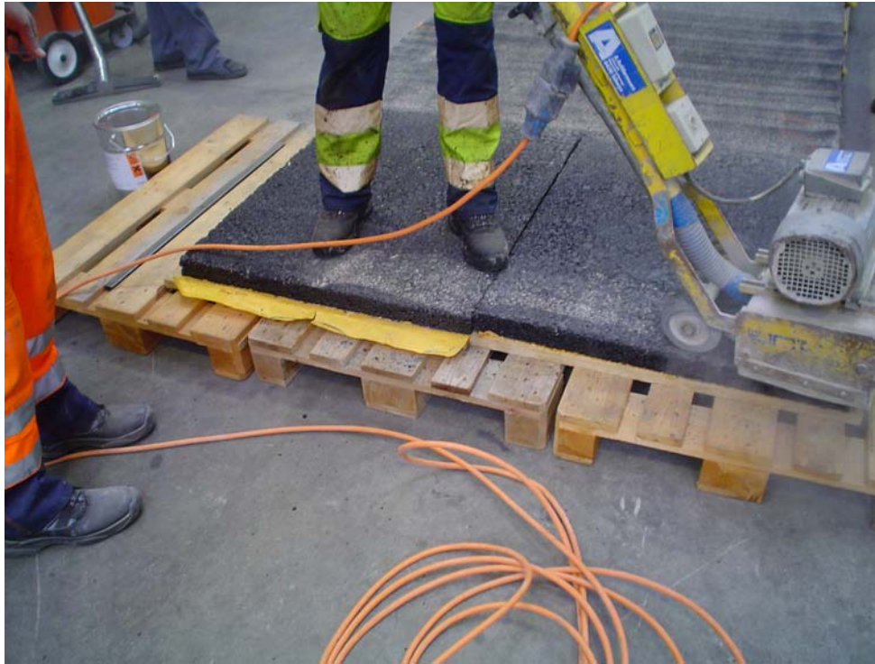
Abbildung 9.6.1: Fräsen der Platte 5 und 6 mit einer Handfräse
