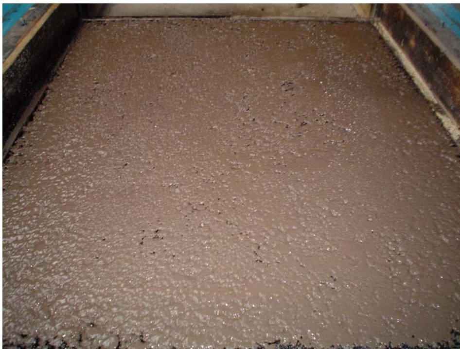
Abbildung 9.9.2: Platte 9 nach Aufbringen des mit Wasser gemischten Feinkorunds, Nahaufnahme
