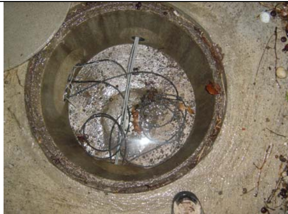
7. Schacht 2: Kein Wasser keine Schäden
