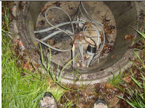
6. Schacht 1: Kein Wasser keine Schäden
