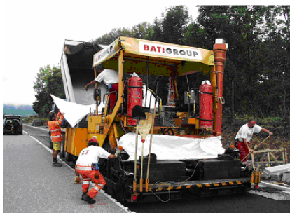
Abbildung 22: Umgebauter Fertiger in Wiggertal (links), Einrichtung für \text{SF}_6 Zudosierung und Absaugung (rechts).
