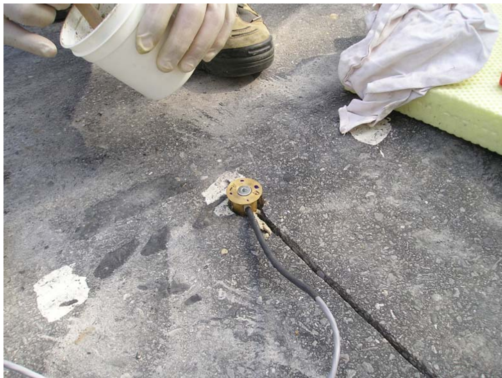
Bild 90 Sensoreinbau
