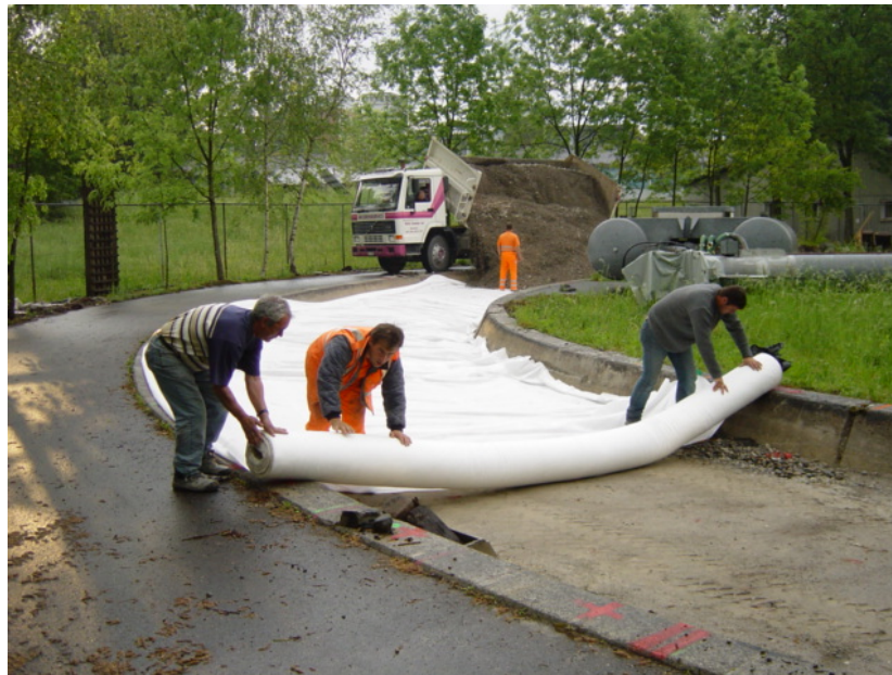
Bild 76 Geotextil verlegen
