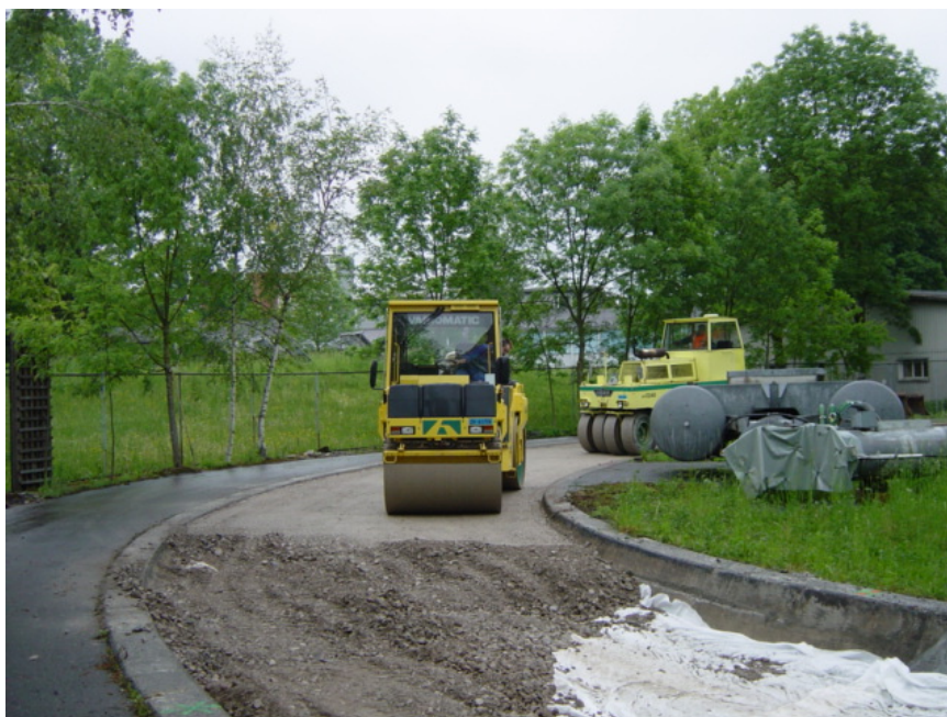
Bild 77 Verdichtung der Foundationsschicht
