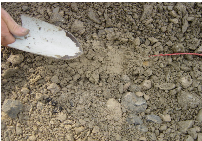
Bild 80 Temperatursensoren mit Sand bedeckt
