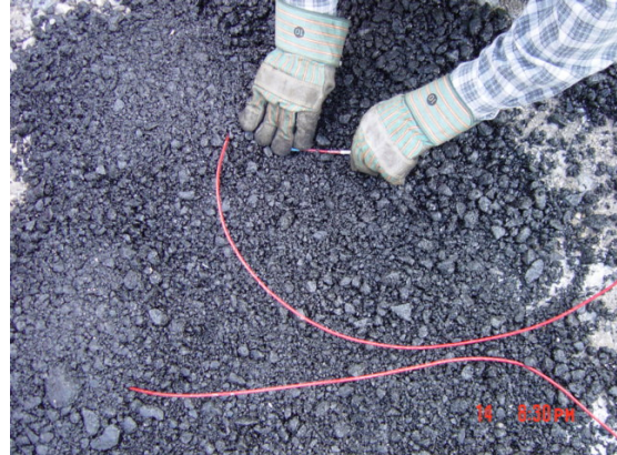
Bild 84 Einbau der PT100 Sensoren
