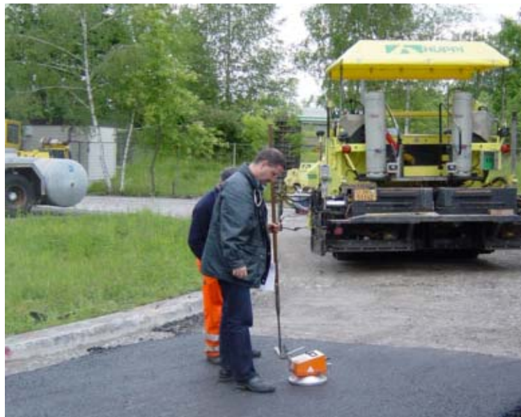
Bild 82 Kontrolle der Mischgutedichte
