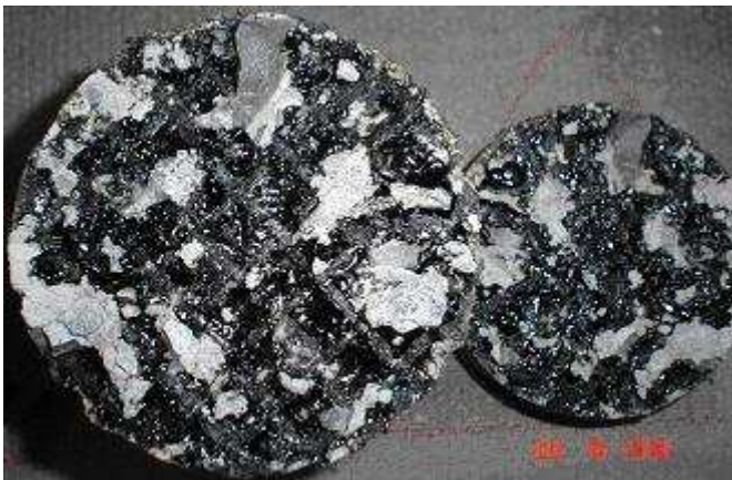
Abbildung 5.17: Bruchbilder der Haftzugprüfung an Bohrkern aus Feld 4
