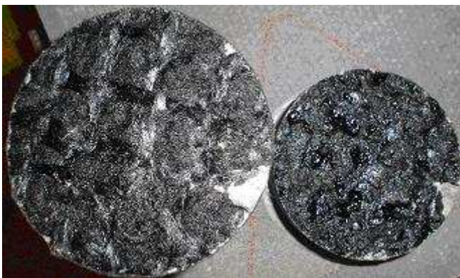
Abbildung 5.15: Bruchbilder der Haftzugprüfung an Bohrkern aus Feld 2
