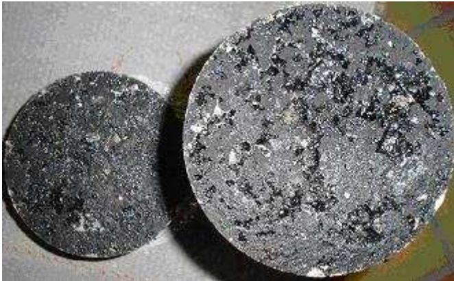
Abbildung 5.19: Bruchbilder der Haftzugprüfung an Bohrkern aus Feld 6
