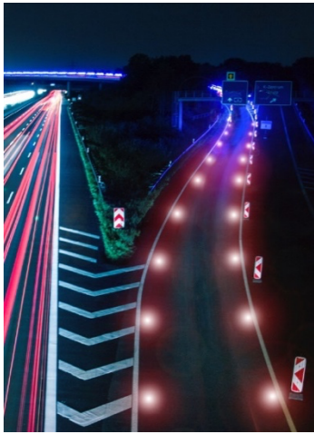
Abb. 5 Dynamische LED-Bodenlichter an einer Autobahnausfahrt [65].
