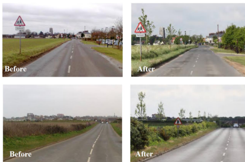
Abb. 7 Anordnung von Bäumen am Strassenrand in abnehmendem Abstand (oben rechts) oder mit zunehmend geringerem seitlichem Abstand zur Fahrbahn (lazy diagonal, unten rechts, [67], zitiert nach [68]).
