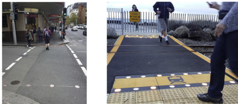
Abb. 23 LED-Bodenlichter an einer Kreuzung und an einem Bahnübergang [115].
