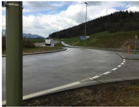
Abbildung 21: Blickrichtung Baden, Kreisel mit Gefälle und «Knick» (innerhalb der Norm).
