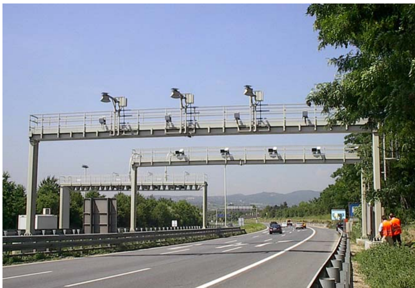
Abbildung 6-5: Abbuchungs- und Enforcement-Stelle LKW-Maut Österreich
