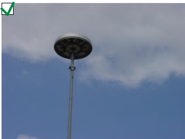
Gut: Weder Leuchtkörper noch Schutzgläser ragen unter der Abdeckung heraus, die Lampe ist horizontal montiert.
