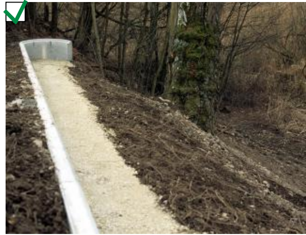
Ein Umkehrelement am Ende des Leitwerks kann die Umgehung der Anlage verhindern.
