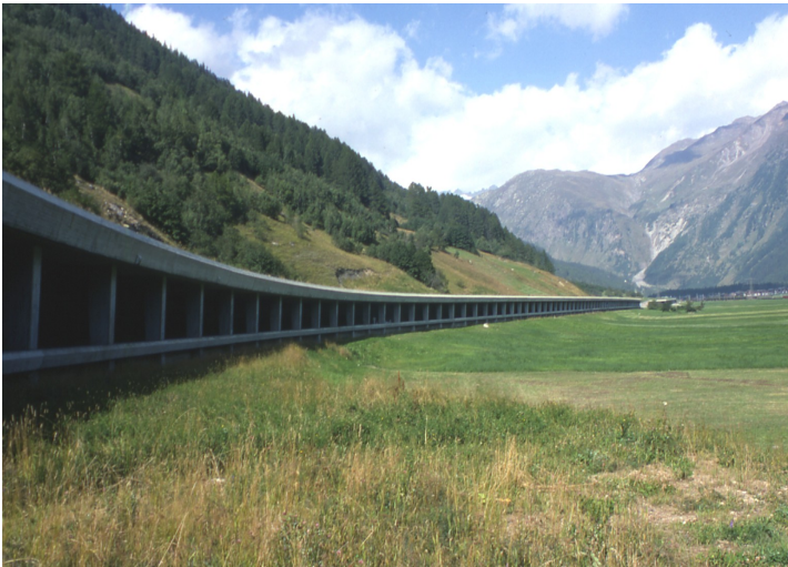
Abbildung 1: Die Lawinenschutzgalerie bei Obergesteln (VS) als Beispiel für ein Infrastrukturelement mit sehr hoher Barrierewirkung. (Foto: M. Trocmé).
