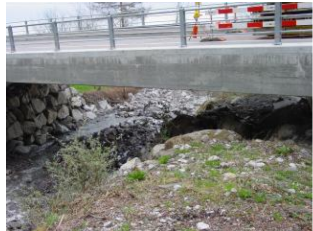
Gewässerdurchlass mit Uferstruktur für die terrestrische Fauna.
