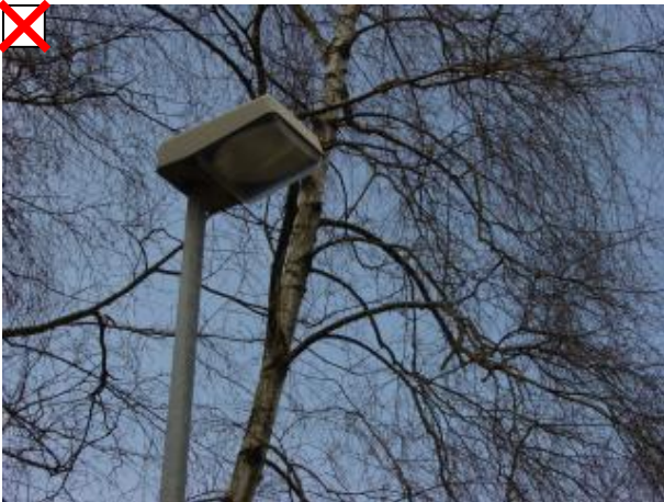
Auch dieses Modell erfüllt die strengen Full-Cutoff-Kriterien wohl nicht vollumfänglich.
