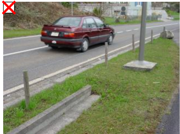
Hier fehlt ein Umkehrelement!
