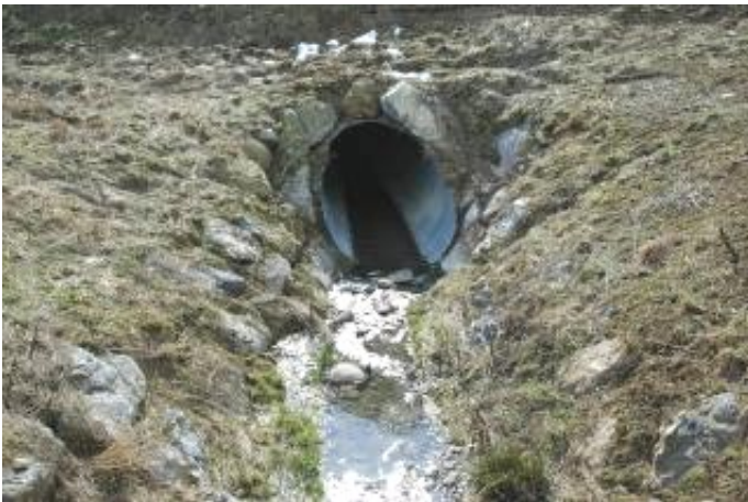
Abbildung 12: Dunkle Durchlässe mit unnatürlichem Grund und monotoner Strömung sind eine Barriere für Fische und andere aquatische Lebewesen.
