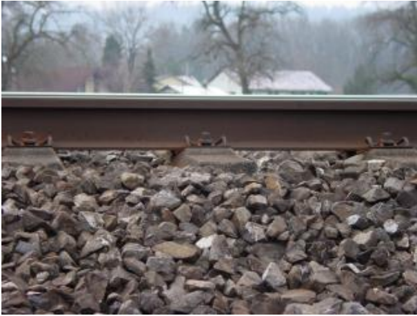
Natürlicherweise entstandene Lücken unter Bahngeleisen, die bei Wartungsarbeiten am Gleisbett aber wieder verschlossen werden.
