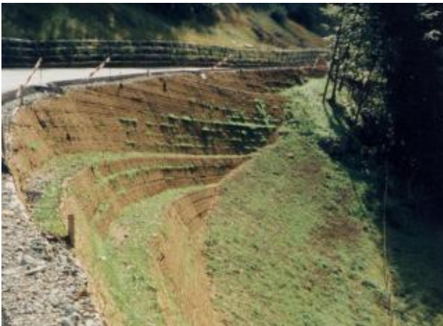
Eine noch weitgehend unbewachsene Textomur-Stützkonstruktion. Foto: M. Trocmé
