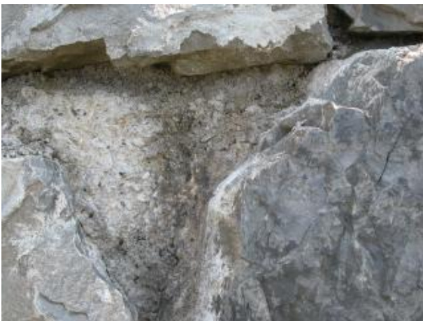
Ritzen und Nischen einer unvollständig vermörtelten Mauer.
