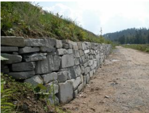
Trockenmauer als vorgelagerte Ergänzung eines Dammes.
