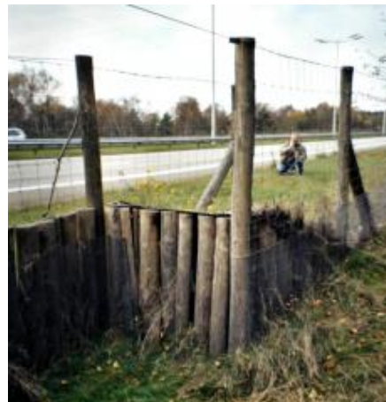
Ausstiegsrampe, parallel zur Fahrbahn gelegen.
