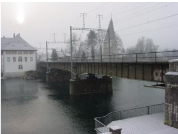
Eisenbahnbrücke in Solothurn West. Um zu verhindern, dass Wasservögel mit der Oberleitung kollidieren, wurden kleine Plastikspiralen aufgehängt.
