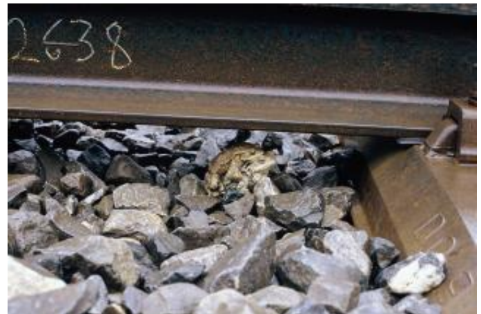
Ein Erdkrötenpaar benutzt eine Lücke unter den Bahnschienen bei Rietheim. Der Schotter ist hier absichtlich tief planiert worden, damit solche Lücken erhalten bleiben.
