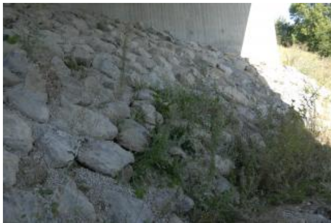
Zwischen den Steinen haben sich bereits Pflanzen angesiedelt.
