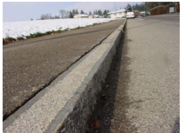
...während senkrechte Randsteine für viele Kleintiere eine erhebliche Barriere darstellen.
