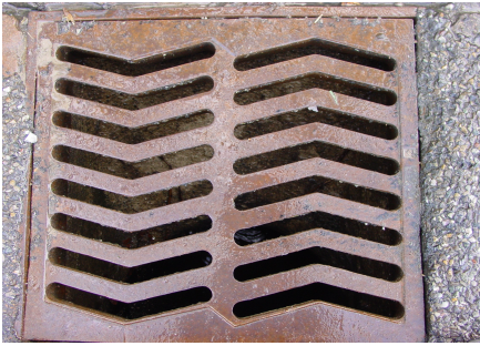
Abbildung 7 (oben): Der Einlaufschacht als Falle für Kleintiere; ein altbekanntes Problem...
