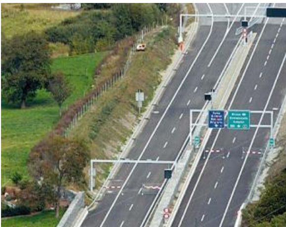
Ein Lärmschutzwall an der A9 bei Gamsen (VS).
