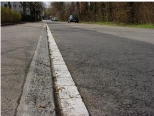
Schräge Randabschlüsse ermöglichen den Kleintieren ein leichtes Verlassen der Fahrbahn...
