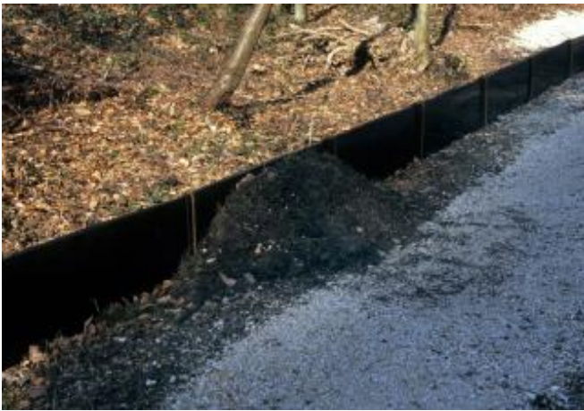
Solche Rampen ermöglichen Tieren, die in die Gegenrichtung ziehen, einen Ausstieg aus der Fahrbahn (wenn die andere Seite nicht gesichert ist oder der Zaun umgangen wurde). Foto: Oekovision GmbH, 8967 Widen
