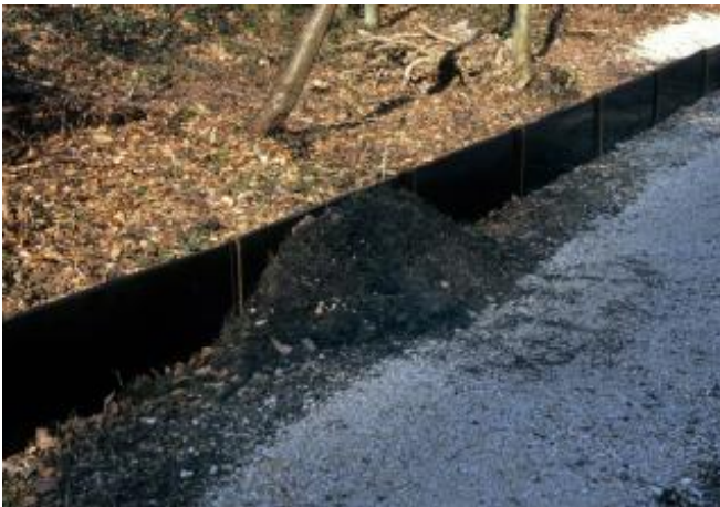
Solche Rampen ermöglichen Tieren, die in die Gegenrichtung ziehen, einen Ausstieg aus der Fahrbahn (wenn die andere Seite nicht gesichert ist oder der Zaun umgangen wurde). Foto: Oekovision GmbH, 8967 Widen
