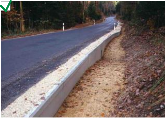
Eine freie Lauffläche erhöht die Leitwirkung auf die Amphibien.
