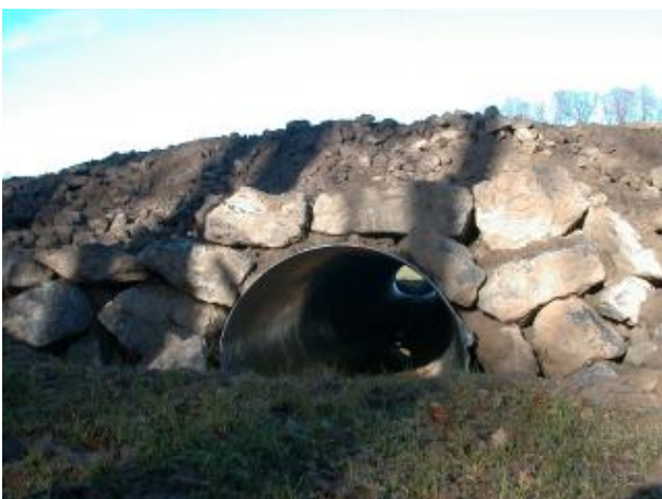
Ein Kleintierdurchlass mit Röhrenprofil. Die meisten Durchlässe werden heute aber mit Kastenprofilen erstellt.
