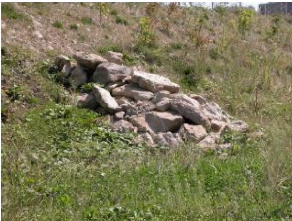
Steinlinse an Böschung
