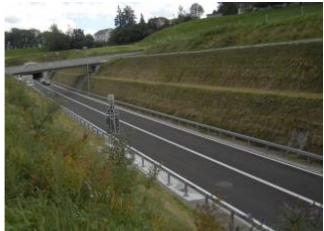
Auf der linken Seite eine relativ magere, artenreiche Wiesenböschung, auf der rechten Seite die steilere, monotone Textomur-Böschung.
