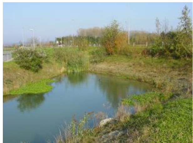
Beispiel für ein naturnahes Retentionsbecken in Strassennähe.
