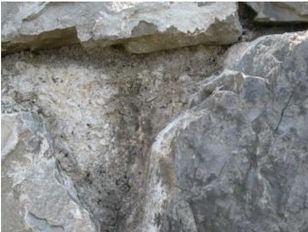
Ritzen und Nischen einer unvollständig vermörtelten Mauer.
