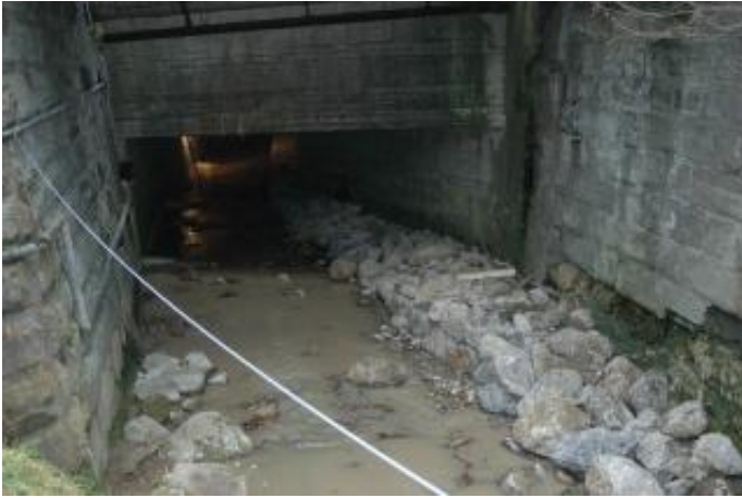
Berme an einem Gewässerdurchlass bei Bazenheid (SG).
