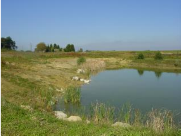
Beispiel für ein naturnahes Retentionsbecken in Strassennähe.
