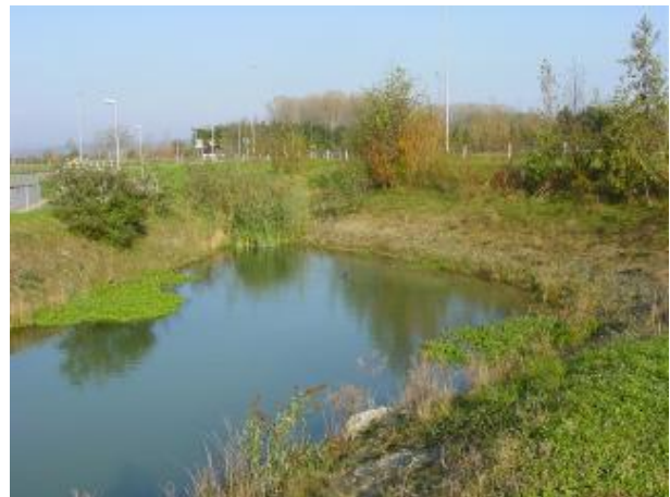
Beispiel für ein naturnahes Retentionsbecken in Strassennähe.
