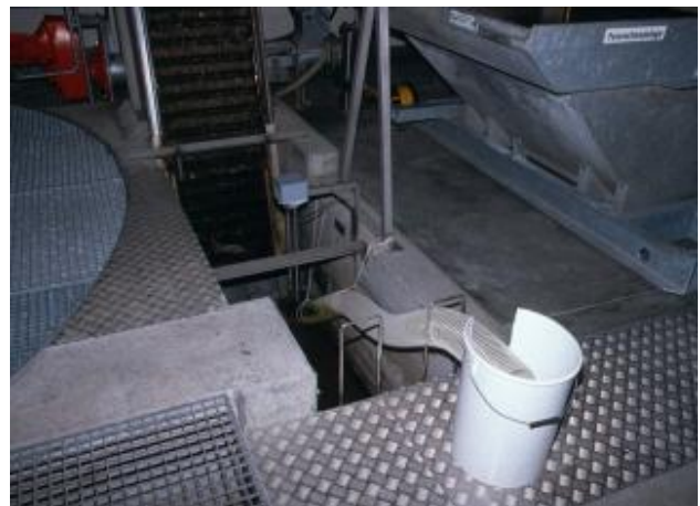
Ausstiegshilfe mit Eimer als Sammelgefäss, welches regelmässig geleert werden muss.
