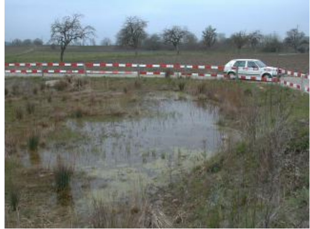
Beispiel für ein naturnahes Retentionsbecken in Strassennähe.
