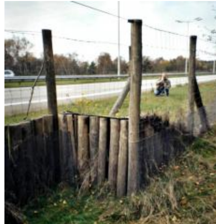
Ausstiegsrampe, parallel zur Fahrbahn gelegen.
