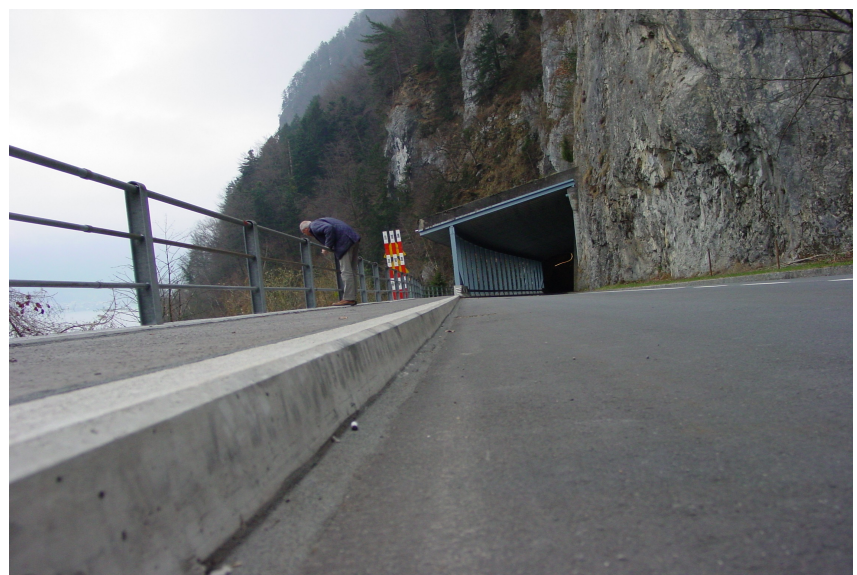
Abbildung 6: Dieser Randstein verwehrt Amphibien die Wanderung ans Seeufer und lenkt sie stattdessen direkt in den Tunnel.
