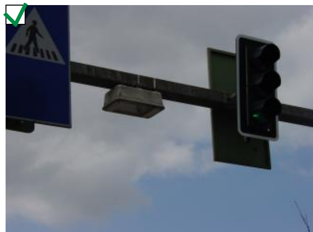
Diese Leuchte erfüllt die Abschirmungskriterien.
