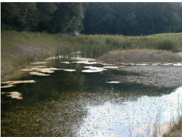
Beispiel für ein naturnahes Retentionsbecken in Strassennähe.
