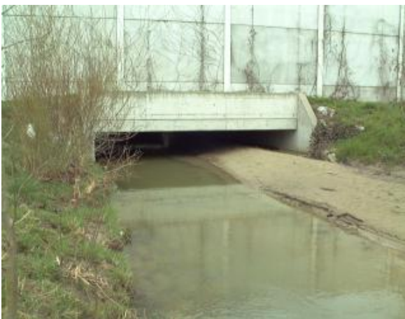
Ein Gewässerdurchlass entlang der A1 (Le Dy) mit Berme für kleinere Wildtiere.
