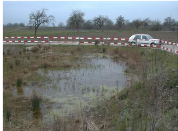
Beispiel für ein naturnahes Retentionsbecken in Strassennähe.
