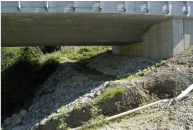
Die Böschung unter der Brücke wurde mit Kalksteinblöcken und Kies gesichert.
