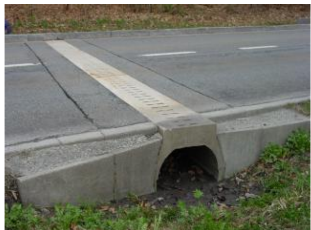
Aco-System: Wenn aus technischen Gründen nicht tief gegraben werden kann, so ist diese Methode oft die einzig mögliche Lösung.
