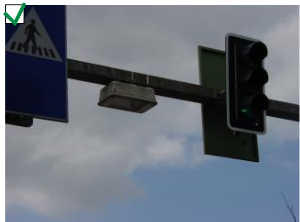
Diese Leuchte erfüllt die Abschirmungskriterien.
