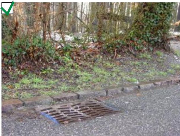
An dieser Amphibienzugstelle bei Frauenfeld wird der Einlauf mit einer Gitterunterspannung des Rostes gesichert.
