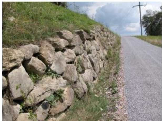
Bruchsteinmauer am Seitenportal eines Tunnels.
