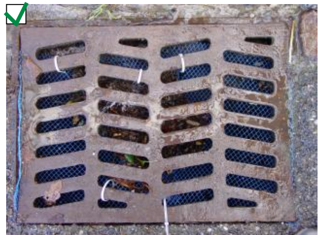
Das Maschengeflecht wurde mit Kabelbindern am Rost befestigt. Das anfallende Laub zwischen Gitter und Rost muss regelmässig entfernt werden.
