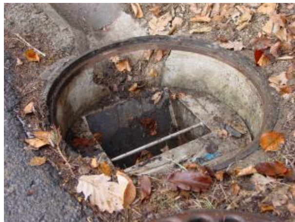
Amphibiensyphon im Ablauf montiert.
