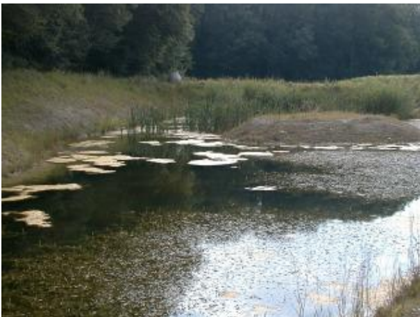
Beispiel für ein naturnahes Retentionsbecken in Strassennähe.
