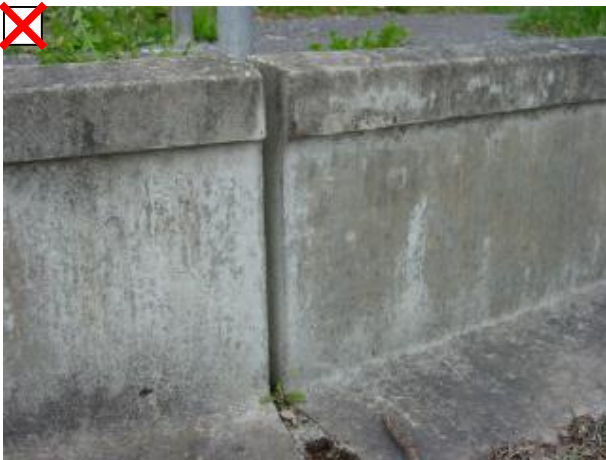
Solche unvermörtelte Spalten ermöglichen den Amphibien, die Sperre zu überklettern.
