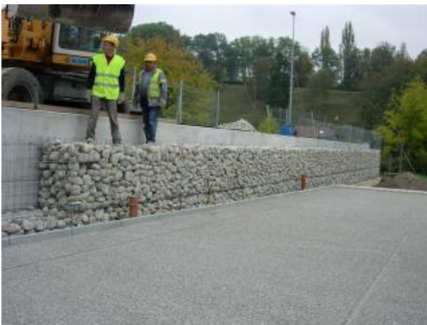
Durch eine Verkleidung mit Steinkörben wird die Mauer für Kleintiere erklimbar. Foto: Füllemann AG, Gossau
