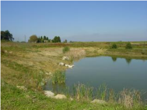
Beispiel für ein naturnahes Retentionsbecken in Strassennähe.
