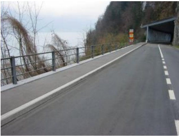
Dieser Randstein bei Bauen (UR) führt Amphibien direkt in den Tunnel, statt zu den Laichplätzen am Seeufer.
