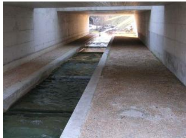
Regelmässige Hochwasser bis zur mittleren Höhe des Durchlasses verhindern, dass hier Deckungsmöglichkeiten für Kleintiere angeboten werden können.
