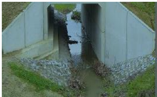
Abb. 3 Naturnah gestalteter Gewässerlauf (Bild aus [53]).
