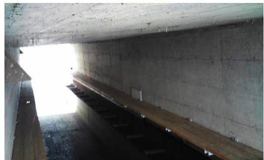
Abb. 4 Nachträglich montiertes Holzbankett.
