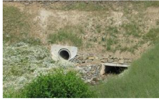
Abb. 6 Trockenröhre neben dem Gewässerdurchlass – für Amphibien nicht geeignete Massnahme (Bild aus [53]).
