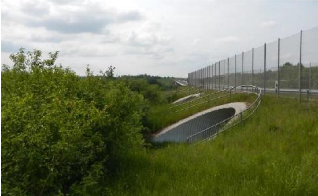
Abb. 10 Wildtierunterführung mit leitenden Strukturen und einem Zaun, der die Fledermäuse dazu bewegt, die Unterführung zu nutzen oder die Strasse oberhalb des Verkehrs zu queren. Aus Lugon A., Eicher C., Bontadina F. (2017) [50].
