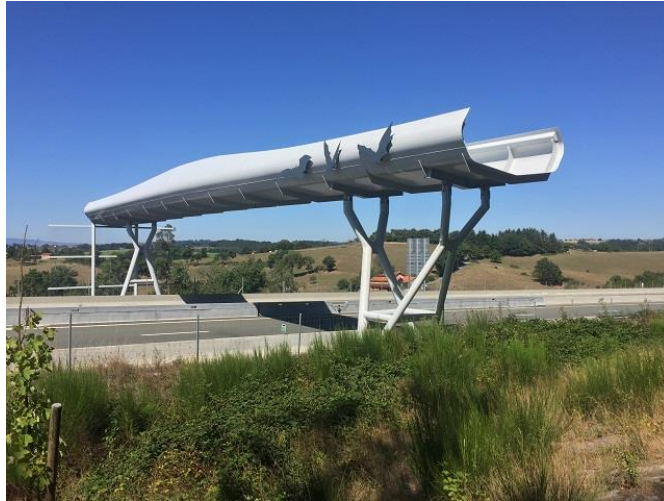
Abb. 13 Chiroptéroduc über die A89. Hier fehlen die zu-führenden Leitelemente. Quelle: www.vigienature.fr/fr/actualites/chauves-souris-effets-negatifs-routes-s-observent-tres-larges-echelle-3595
