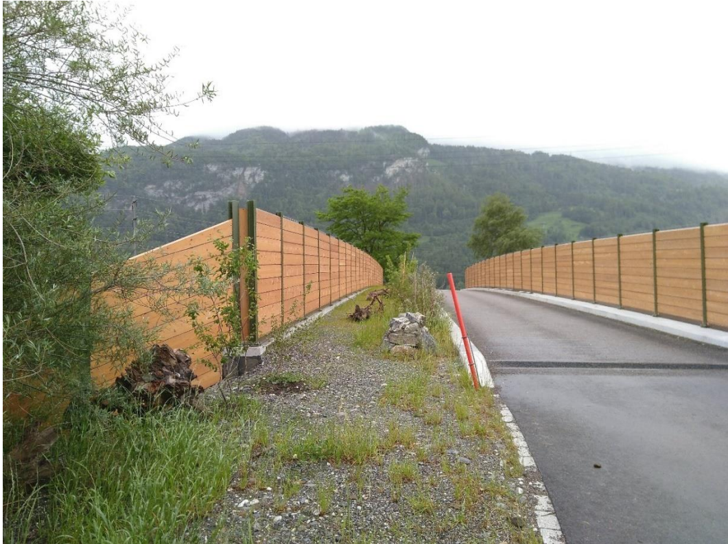
Abb. 2 Beispiel einer Überführung, welche mittels eines Grünstreifens als multifunktionales Bauwerk für die Fauna umgestaltet wurde.
