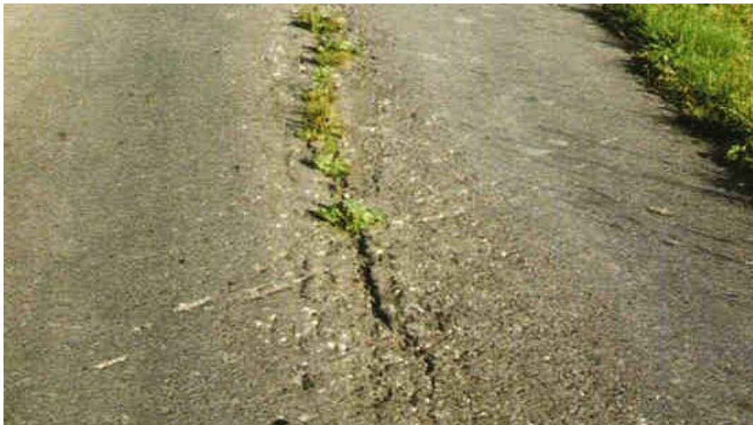
Fig. 64 Fissure de gel
