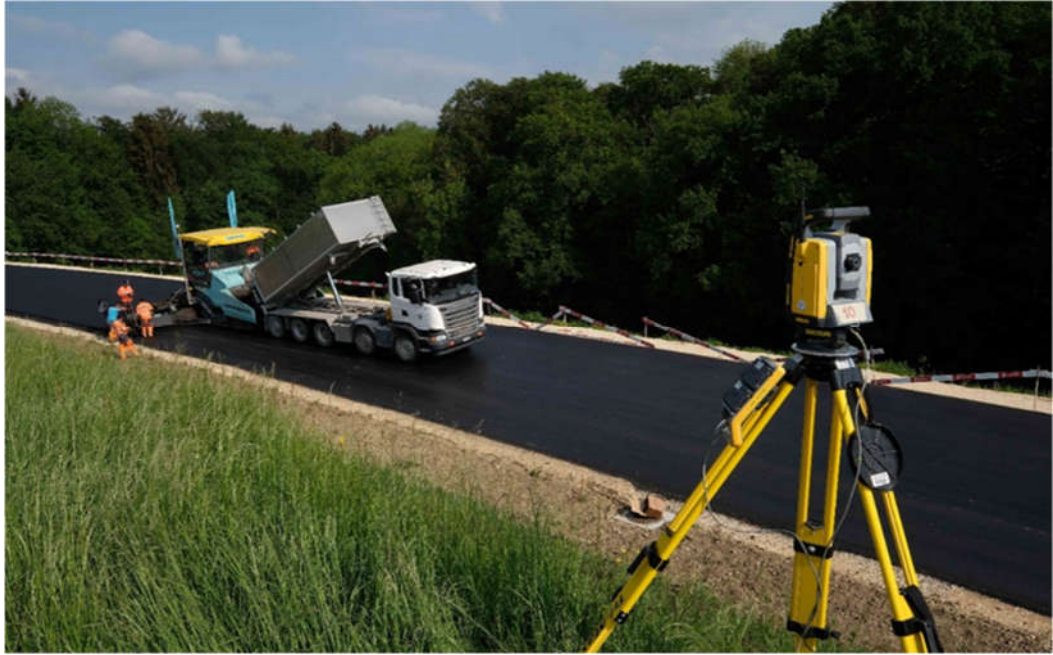
Fig. 22 – Pose 3D de la couche n-2 sur la RC177, avec station totale robotisée (© Eric Frigière)
