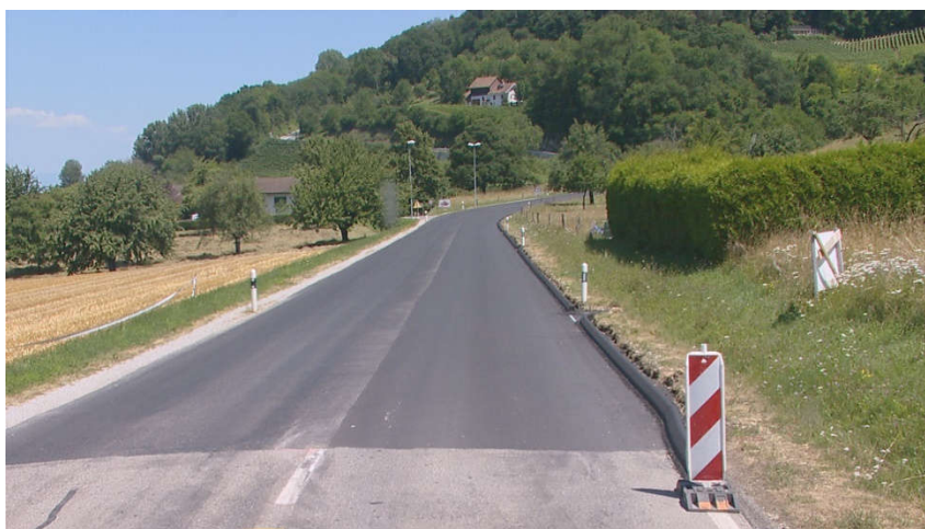
Fig. 26 – Traversée de Cheyres – Couche de roulement déjà posée sur 150m lors de l'intervention sur la couche n-1
