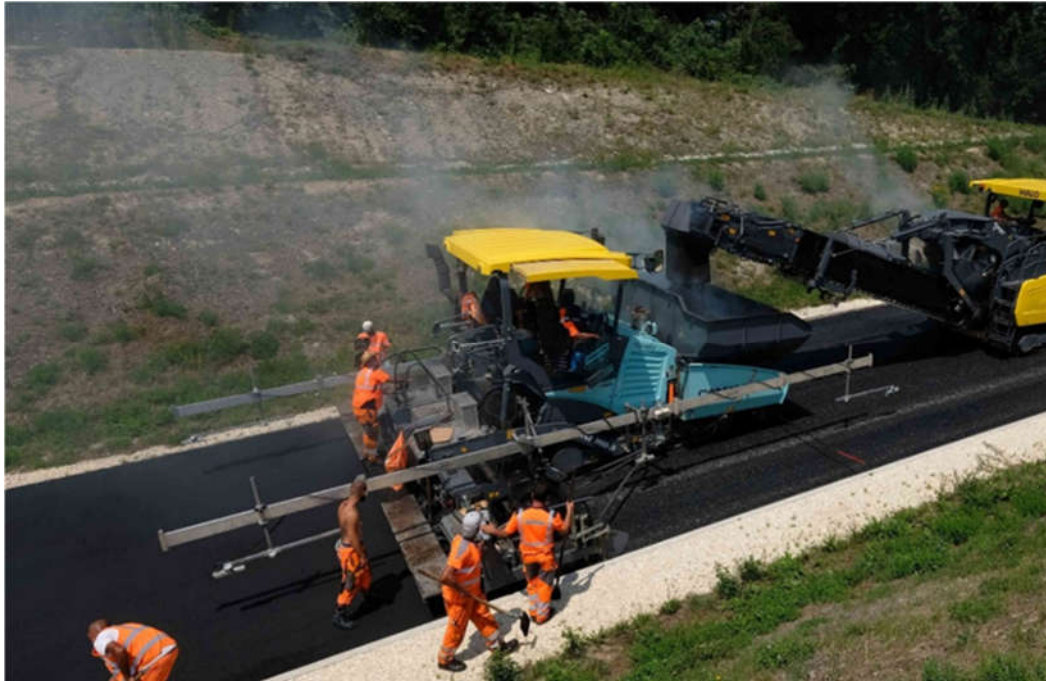
Fig. 21 – Exemple de poutre enjambeuse pour la pose de la couche n-1 sur la RC177 (© Eric Frigière)
