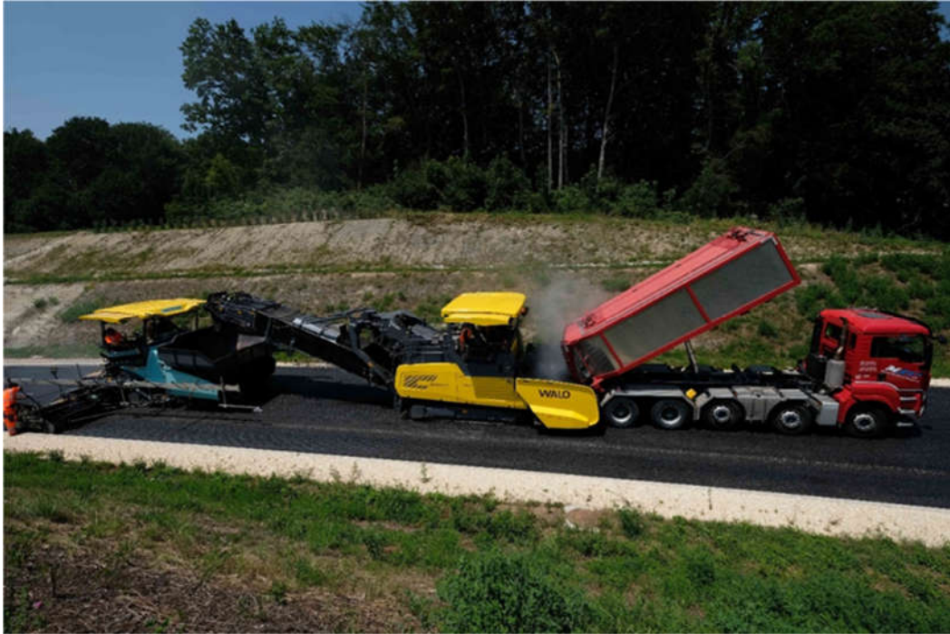
Fig. 23 – Alimentateur entre les camions et le finisseur (© Eric Frigière)
