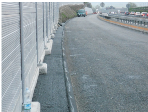
Abb. 42 Versiegelte Fläche zwischen Lärmschutzwand und Fahrbahn (Foto: M. Hürlimann, Gruner Berchtold Eicher AG).
