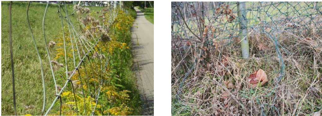
Abb. 35 Typische Probleme im Bereich des Zaunfusses.
