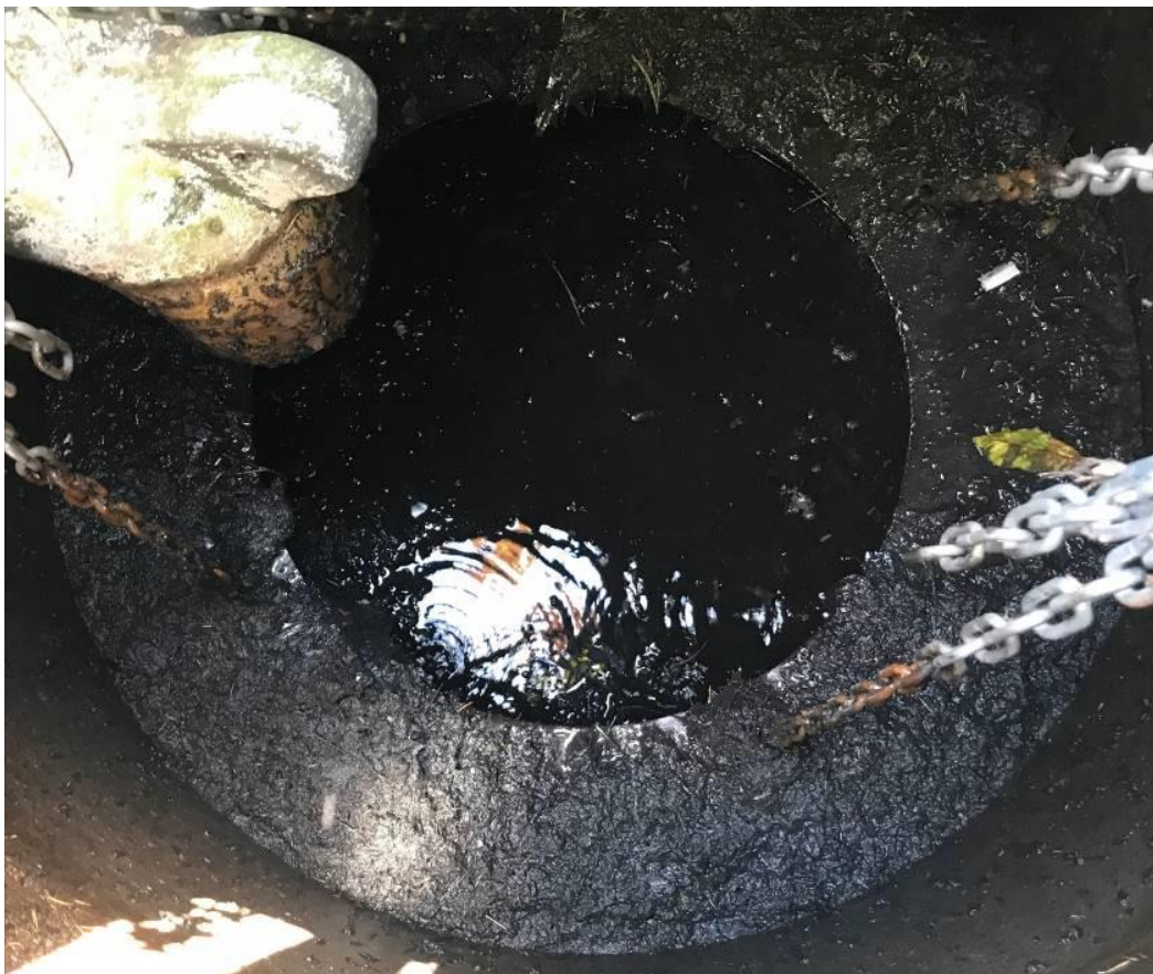
Abb. 37: Schlamm auf dem Kranz nach einem Jahr beim Entleeren des Sammlers
