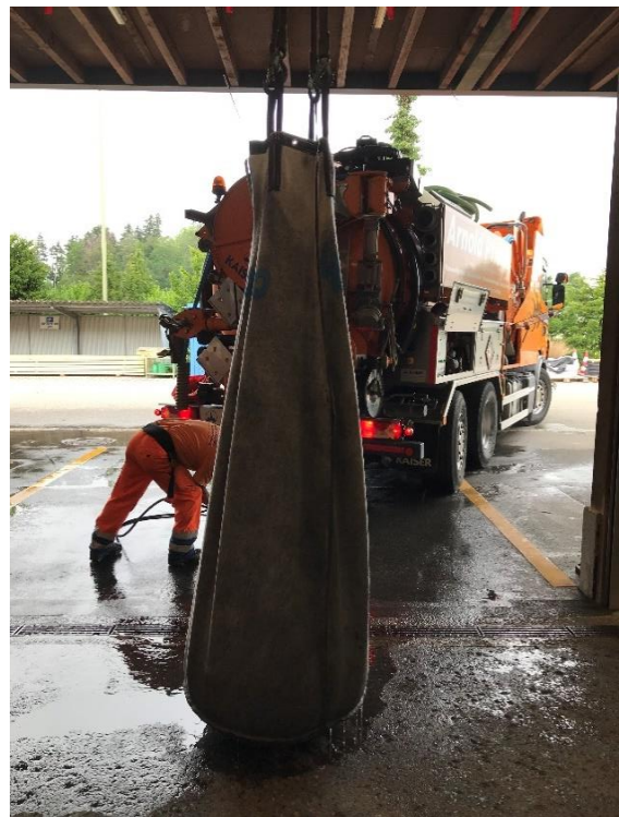
Abb. 12: Befüllter Filtersack zum Abtropfen aufgehängt
