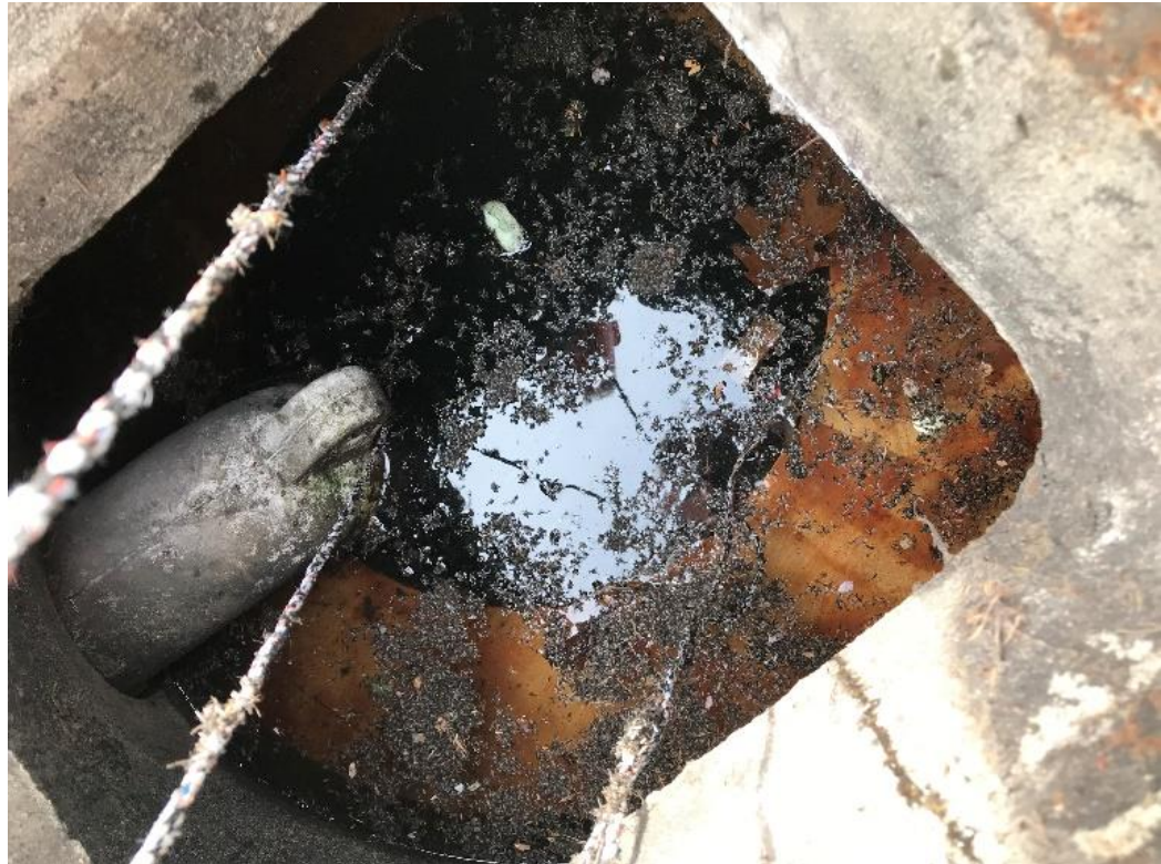
Abb. 29: Nachrüsteinheit aus Holz im Schlammsammler "geöffnet"
