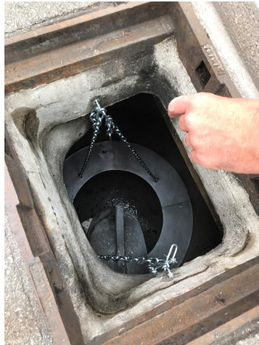
Abb. 31: Eingebaute Nachrüsteinheit mit Durchmesser von 1m
