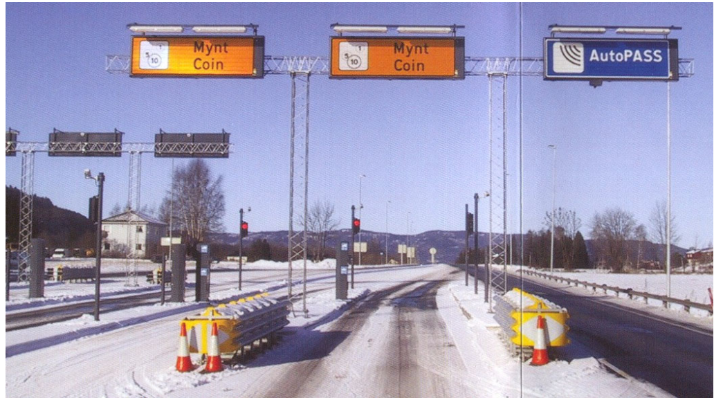
Figur 8 Zwei Spuren sind mit Münzautomaten und eine Spur mit DSRC Funkbaken („AutoPASS“) ausgerüstet.
