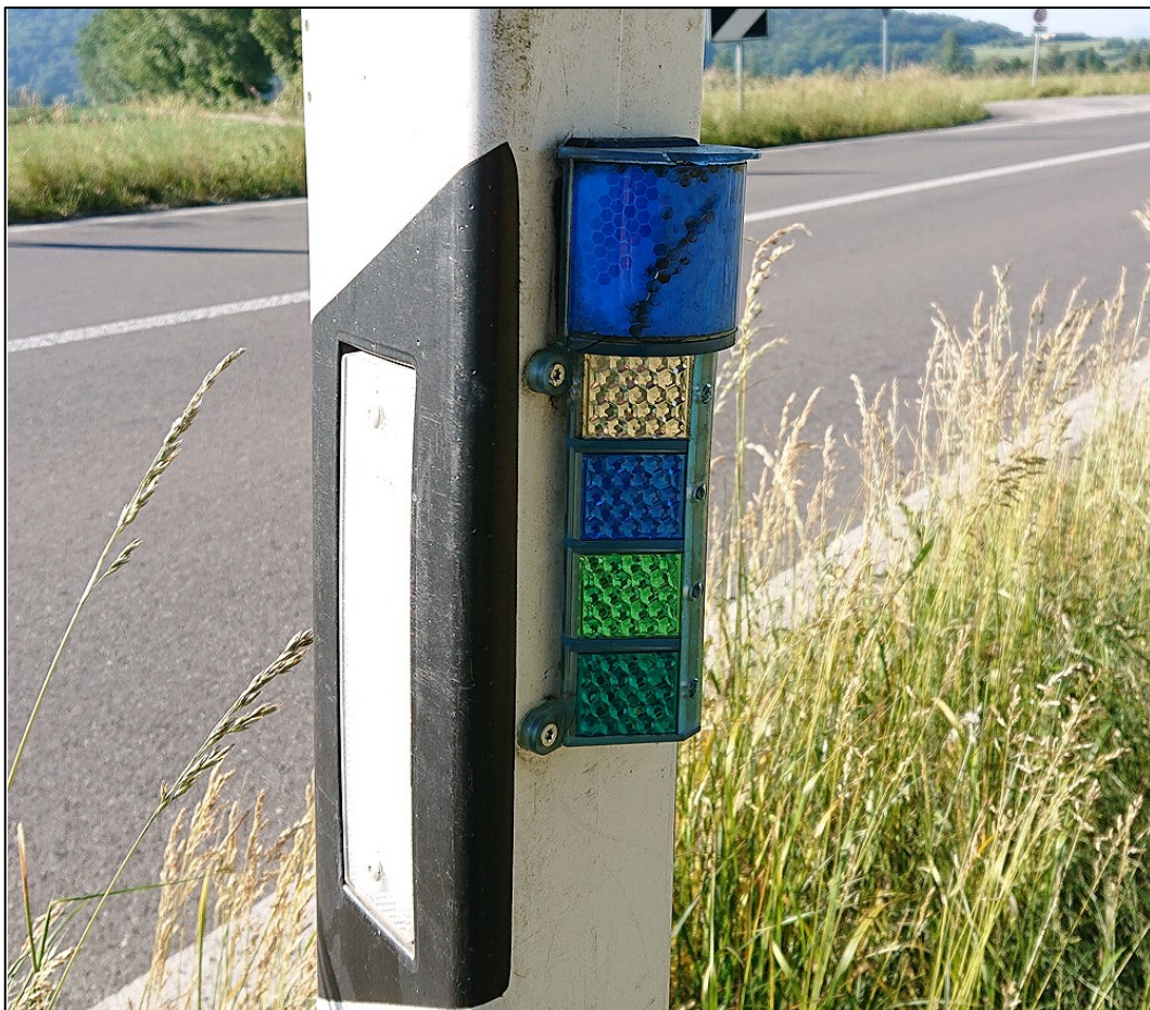
Abb. 21: Olfaktorische Wildwarner oder sogenannte "Duftzäune" werden eingesetzt, um Wildtiere von Strassen fernzuhalten und so Unfälle auf der Verkehrsinfrastruktur zu verhindern. Das Bild zeigt einen kombinierten Wildtierwarner (olfaktorisch und visuell). Die Flüssigkeit mit dem Geruch wird in das obere blau reflektierende Reservoir gegeben. © WLS.CH
