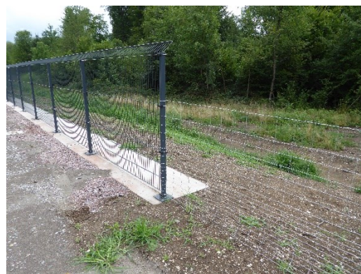
Abb. 17: Typ 3: Stabgittermatten mit unterschiedlichen Drahtstärken. Hier eine Ausführung mit Flügel als Überspring- und Überkletterschutz. © Martin Strein
