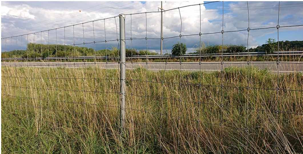
Abb. 18: Typ 2: Knotengitter mit unterschiedlichen Maschenweiten. © ZHAW WILMA
