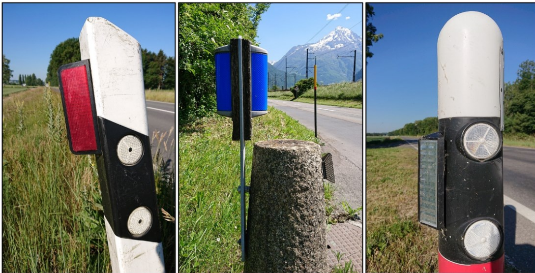
Abb. 19: Visuelle Wildwarner sind Reflektoren in verschiedenen Farben, Formen und Ausführungen, die an Leitpfosten angebracht sind. Trifft Licht aus den Scheinwerfern des Fahrzeugs auf den Reflektor, wird das Licht in die Umgebung abgelenkt und soll Tiere warnen und davon abhalten, auf die Strasse zu gehen, oder sie sogar abschrecken. © WLS.CH
