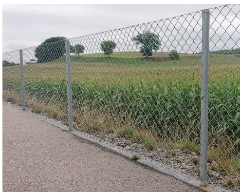
Abb. 16: Typ 1: Diagonalgeflechte mit unterschiedlichen Drahtstärken und Maschenweiten. © ZHAW WILMA
