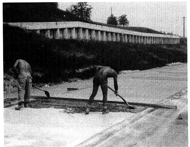
Bild 116: Einbau des Versuchsbelages B. Aufbringen der Schicht aus Kunststoffmörtel.
