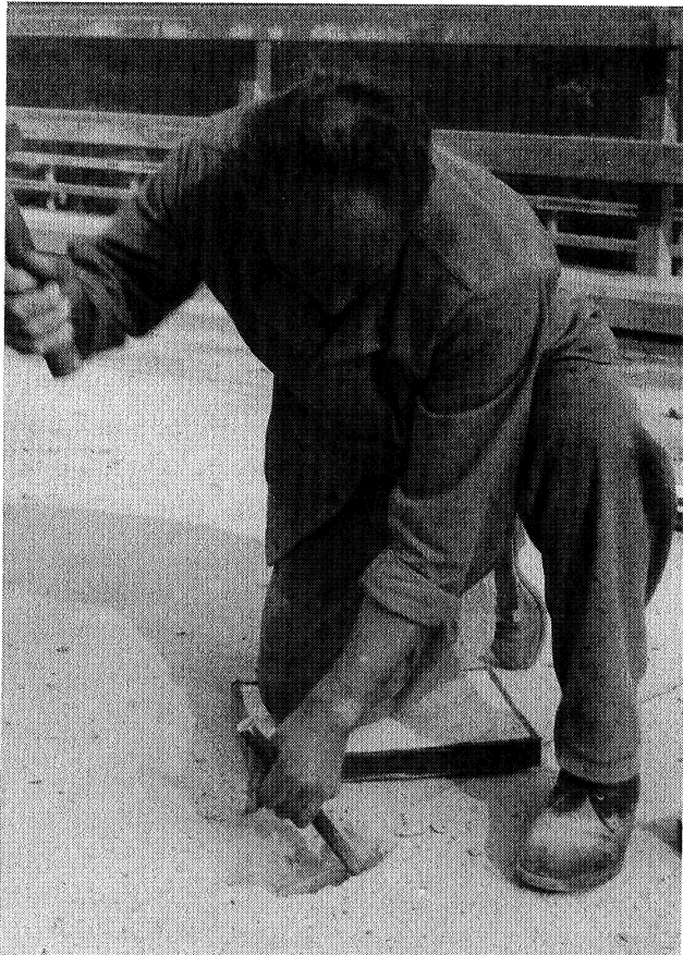
Bild 143: Freilegen der oberen Bewehrung der Fahrbahnplatte.
