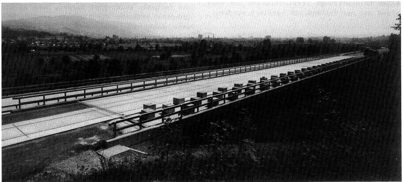
Bild 3: Die Brücken Deibüel im Zuge der Talstrasse T4 bei Baar. Im Vordergrund die Bergspurbrücke.
