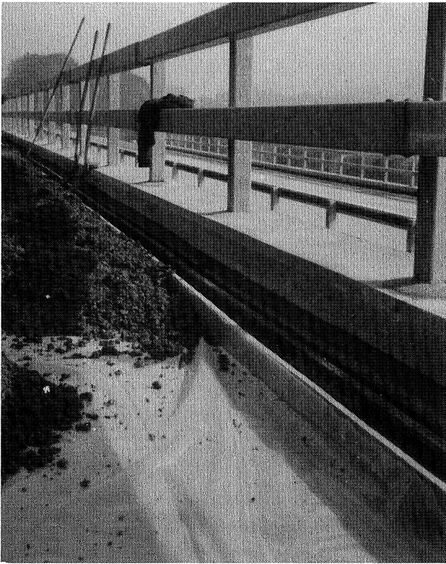
Bild 104: Einbau des Versuchsbelages A. Sichtbar sind die Randabschalung mit der ausgesägten Oberkante und die Plastikfolie für die Trennung des Belages vom Konstruktionsbeton.
