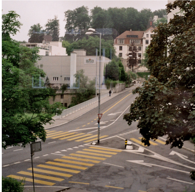
Abbildung 9: Ende Busspur am rechten Fahrbahnrand IV-Spur biegt vortrittsbelastet in Mischspur ein (Luzern)
