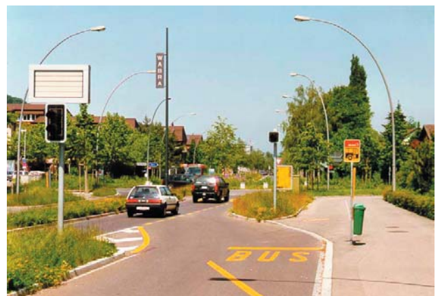
LSA-Regelung für die Priorisierung des Busses gegenüber des MIV vor Kreiselpunkt
