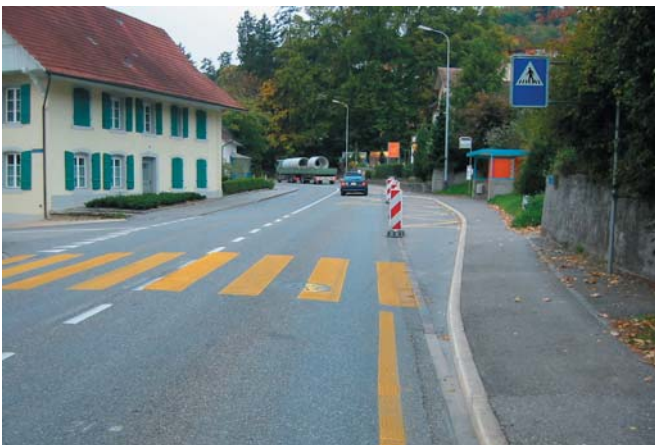
Fahrbahnhaltestelle und Sperrung der Busbucht
