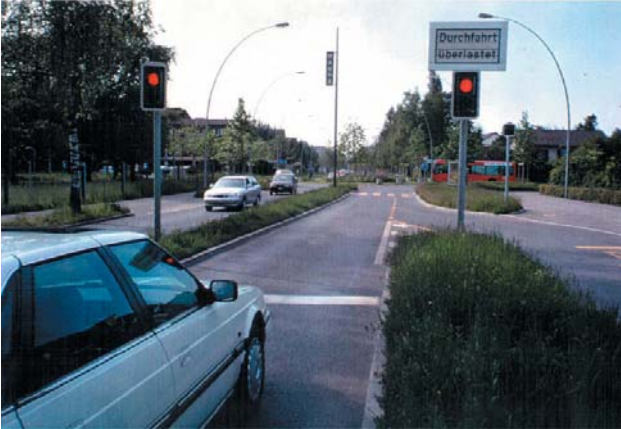
LSA-Regelung bei Überlastung Zentrum, Priorität ÖV
