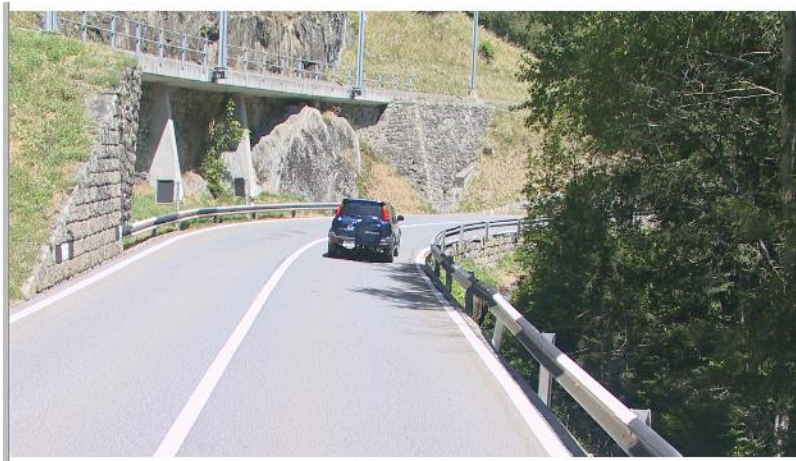
Fig. 48 L'état de surface du tronçon 3
