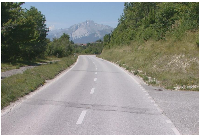
Fig. 46 Présence des fouilles de réparation sur le tronçon 2
