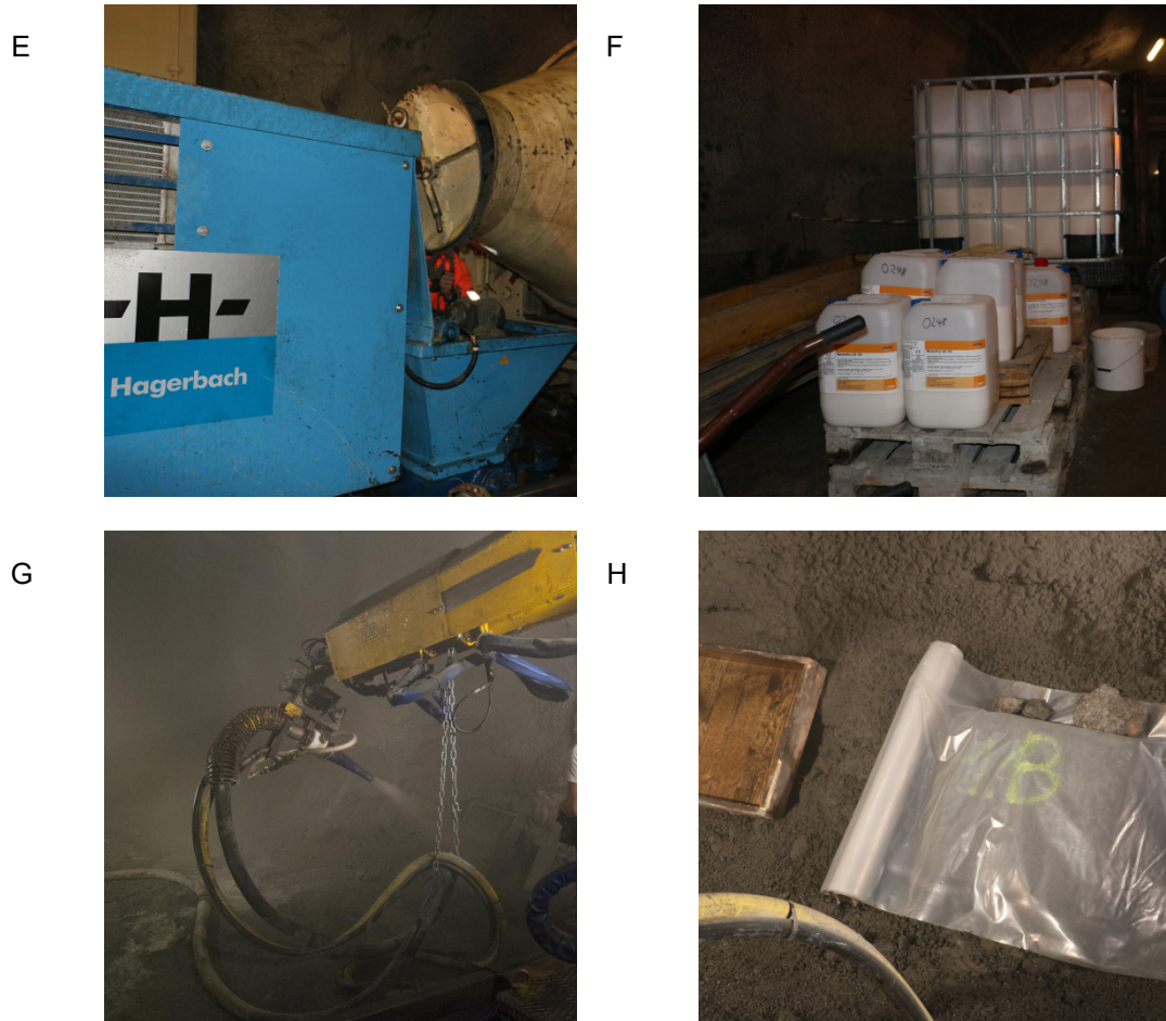
Abb.1 Herstellung von Spritzbeton in-situ. A: Betonmischanlage und Zementanlieferung (hier als Sackware) B: Planetenmischer zur Herstellung des Bereitstellungsgemisches C: Ermittlung des Ausbreitmasses des Bereitstellungsgemisches D: Transport des Bereitstellungsgemisches zur Applikationsstelle E: Betonpumpe F: bereitgestellte Beschleuniger G: Spritzdüse und Applizierung des Spritzbetons H: Abdeckung der frisch hergestellten Prüfplatte.
