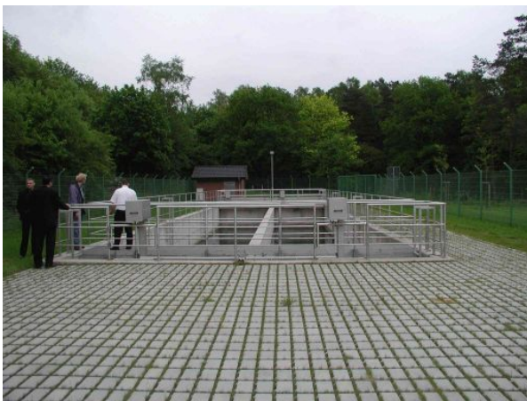
Abbildung 15: Entsalzungsanlage mit seinen zwei Becken (Fotos : W. Bollinger)
