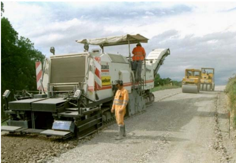
Abbildung 3: Kaltrecycling-Maschine: Fräsen, Mischen und Einbauen in einem Arbeitsgang, erlaubt 100 %-ige Wiederverwendung des Oberbaumaterials
