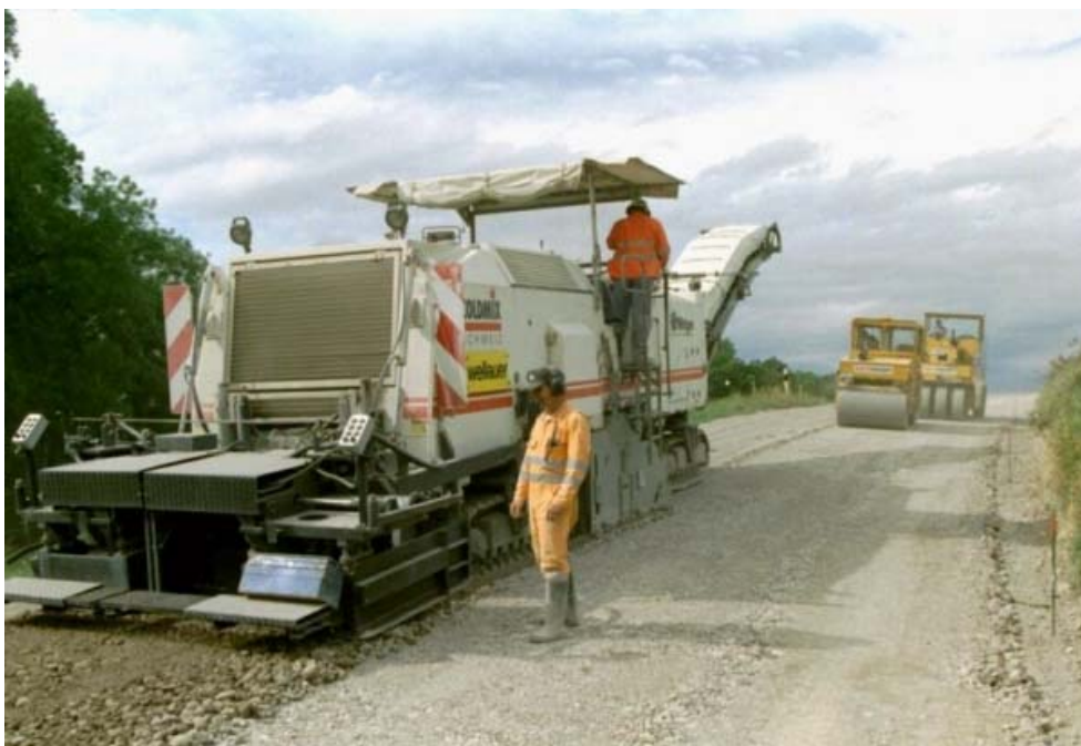
Figure 3 : Machine pour le recyclage à froid : fraiser, malaxer et poser en une étape, permet une réutilisation à 100 % des matériaux de la superstructure
