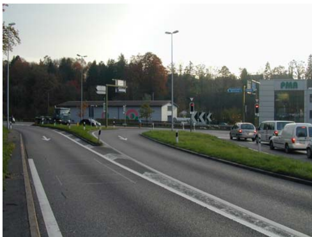
Photo 9: Entrée et sortie d'autoroute
