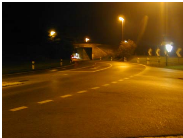
Photo 7: Sortie du passage inférieur
