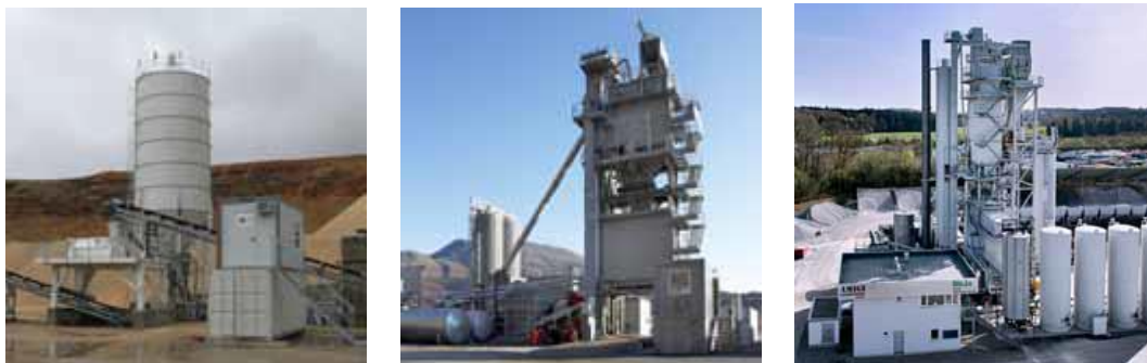
Fig. 4 Exemple de centrales continues et discontinues (Source: Ammann)
