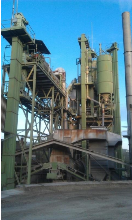
Fig. 19 Photo centrale C
