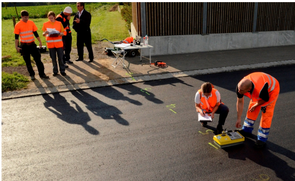
Abb.10 Minutiöse Kontrolle des Einbaus
