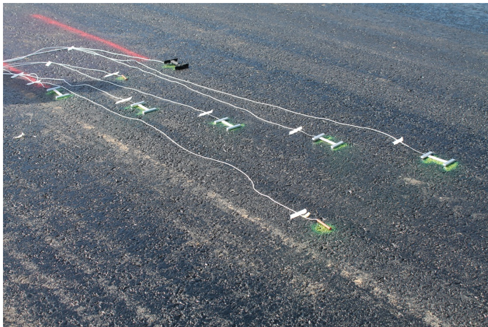
Abb. 21 Verlegung der Messfühler auf der Tragschicht AC T 22S
